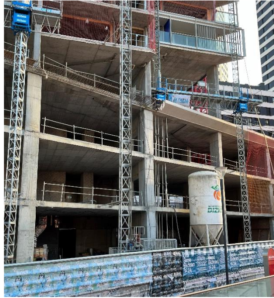
圖 34：外牆作業軌道式升降工作平台
