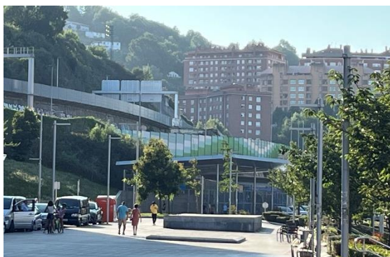
圖 23：高架橋新增交流道工程
