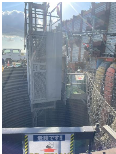
圖 22 地滑整治深基礎樁工程施工期間起降設備
