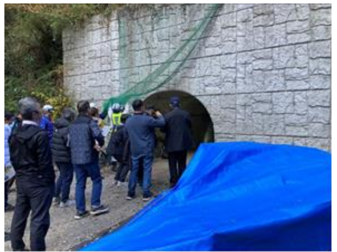
圖 23 地滑整治排水隧道
