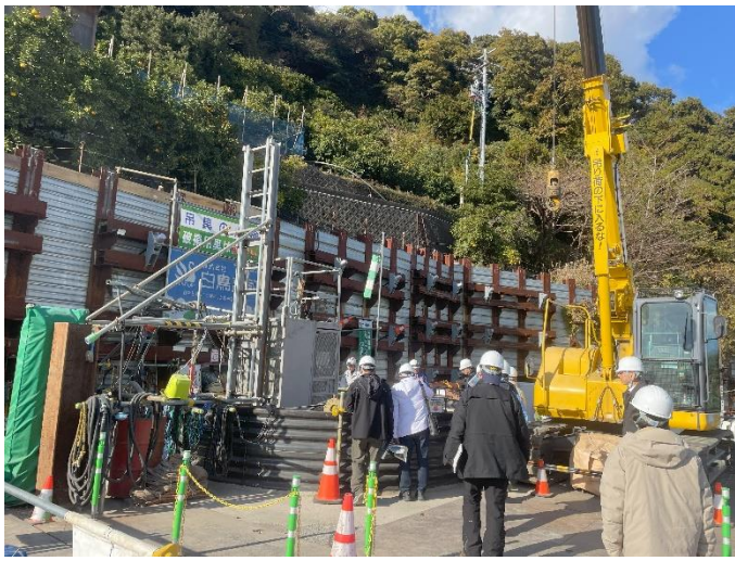
圖 20 地滑整治深基礎樁工程
