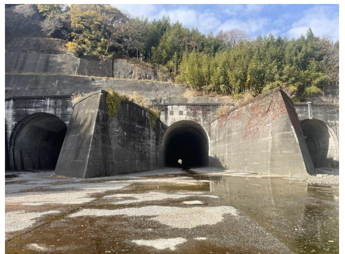
圖 29 狩野川放水路下游排水隧道
