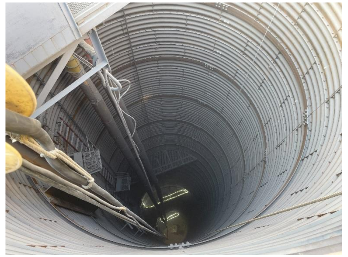
圖 21 地滑整治深基礎樁工程內部
