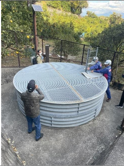
圖 18 地滑整治集水井工程
