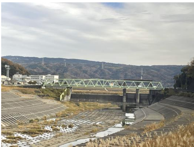
圖 28 狩野川放水路上游閘門
