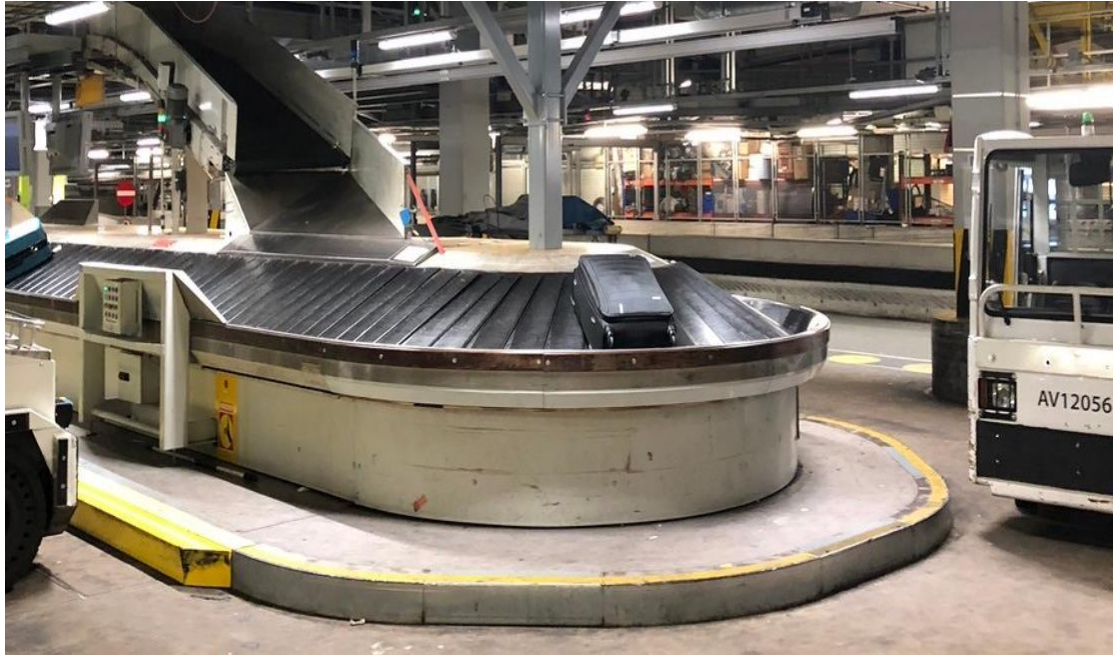
圖 3-21 組裝轉盤區域(資料來源：Schiphol 機場)
