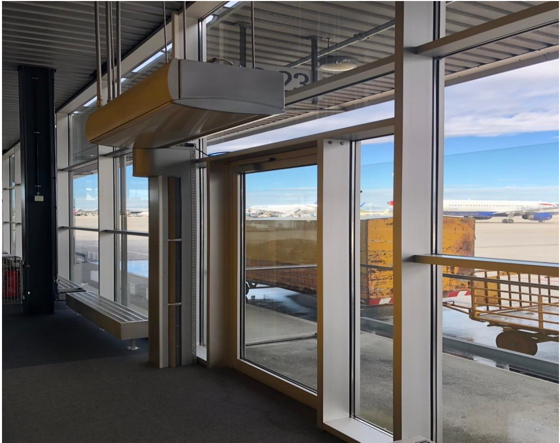
圖 3-33 單開門出入口處空氣簾(資料來源：Munich 機場)
