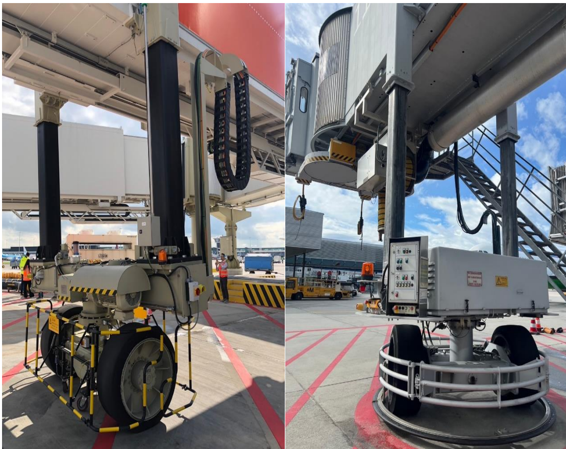
圖 3-29 行駛輪(水平)驅動裝置同步移動防護欄杆 (資料來源：右圖 Schiphol 機場、左圖 Munich 機場)
