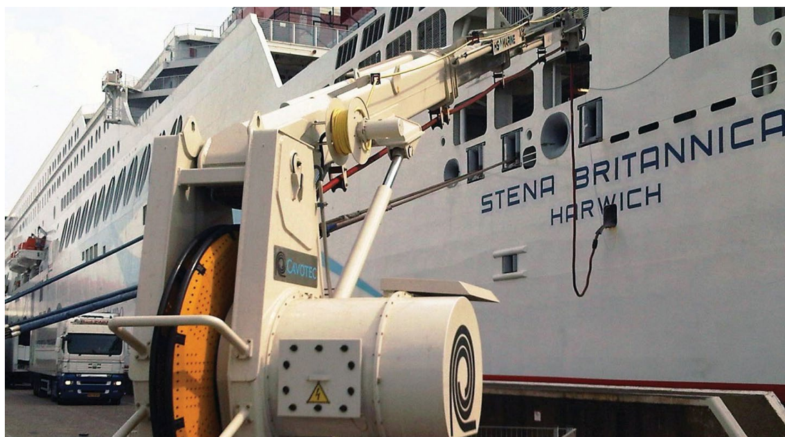
圖 11、郵輪岸電接電示意圖 (圖片來源：Cavotec 官網)
