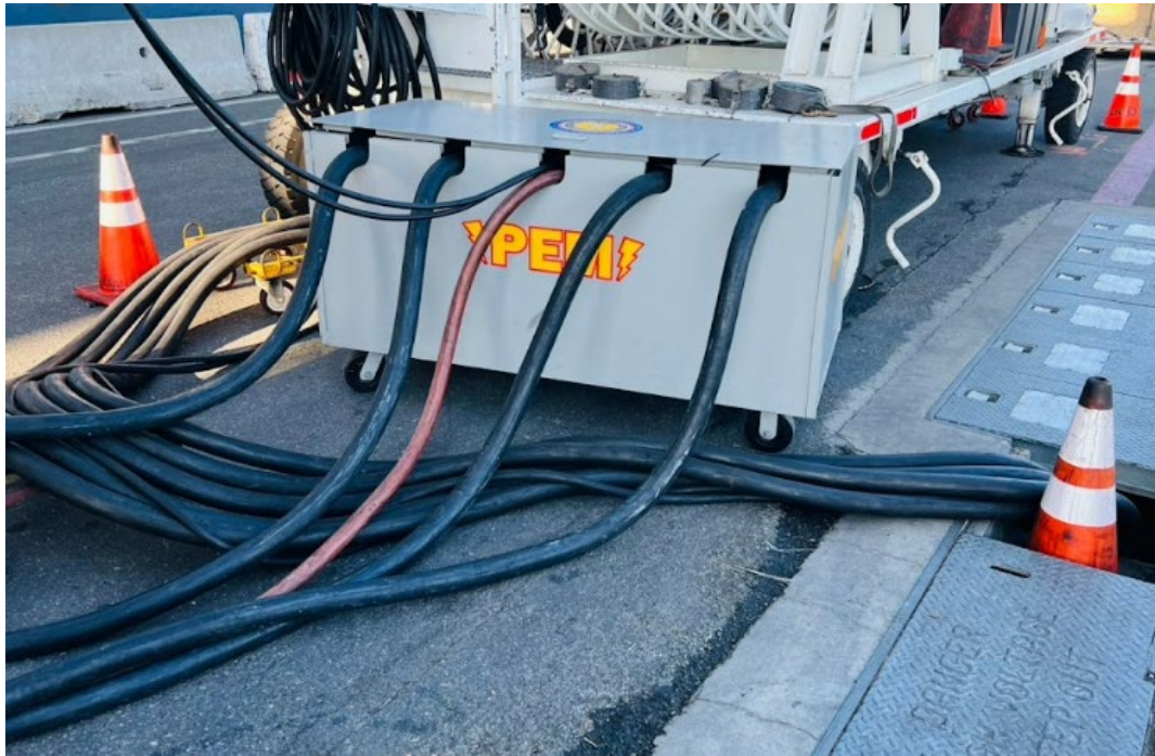
圖 12、Powermove 連接至地下型岸電設施
