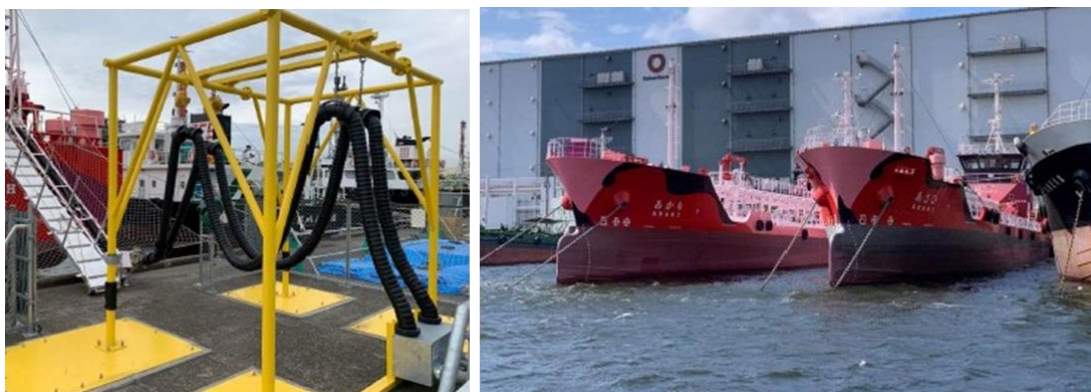
圖 39-岸電設施和電力船
