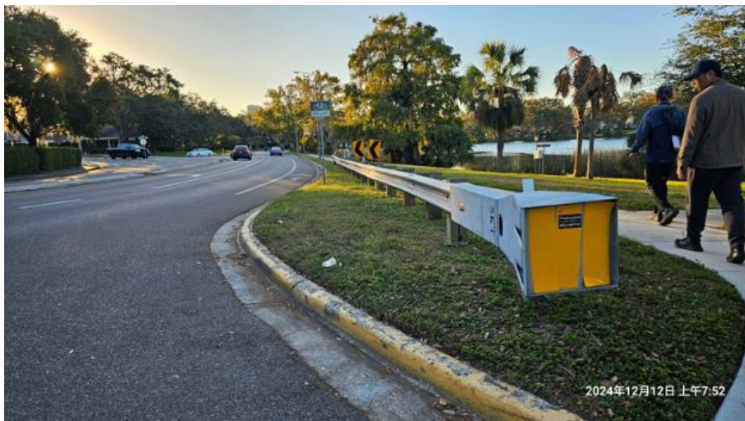
圖 2-2-11 鋼板護欄端部緩衝設施
