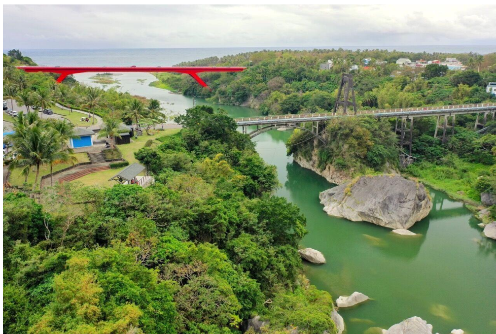
圖 2-2-21 遠眺舊東河橋及新東河橋
