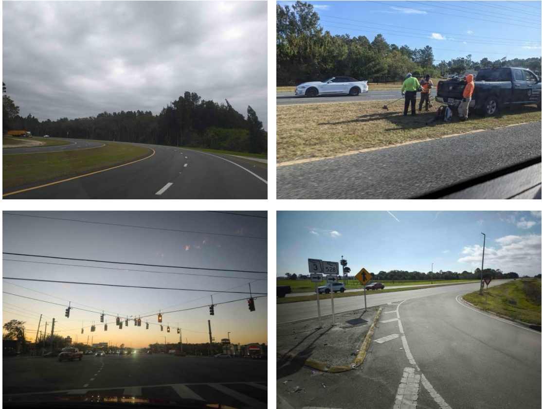
圖 2-3-2 市區道路情形
