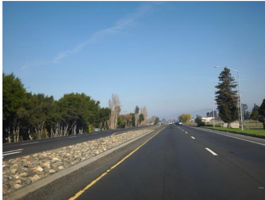
圖 2-2-10 中央分隔帶以石塊或緩坡設置
