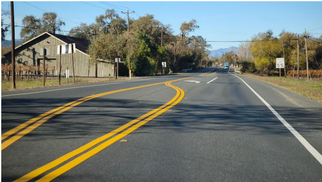
圖 2-2-9-1 加州道路中央左轉車道保護情形
