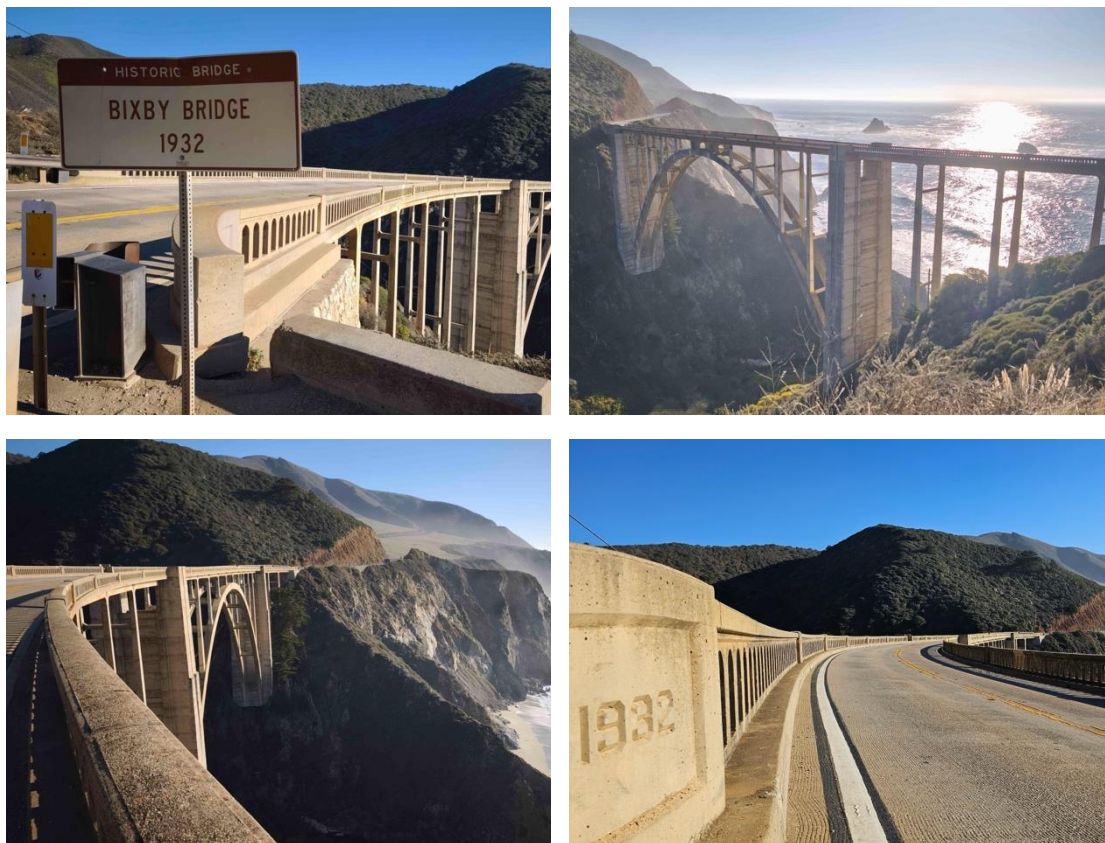
圖 2-2-20 比克斯比溪橋橋形及橋面
