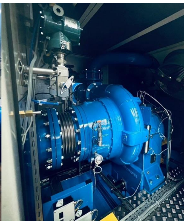
圖 2-3 離心式鼓風機外/內部構造
