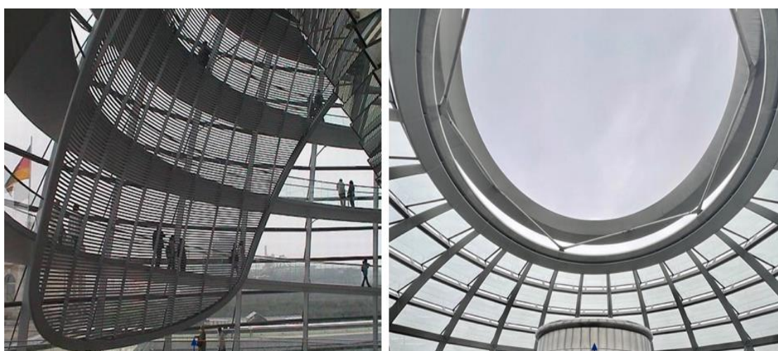
圖 2-19 玻璃圓頂內部採光及通風構造
