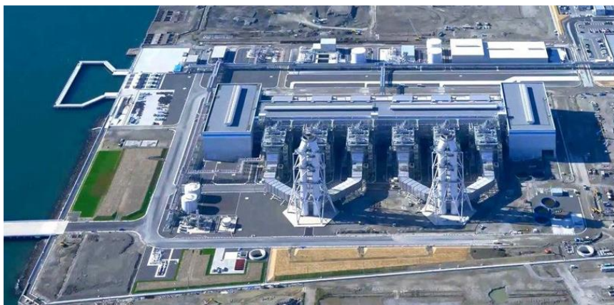
西名古屋火力電廠7號機
