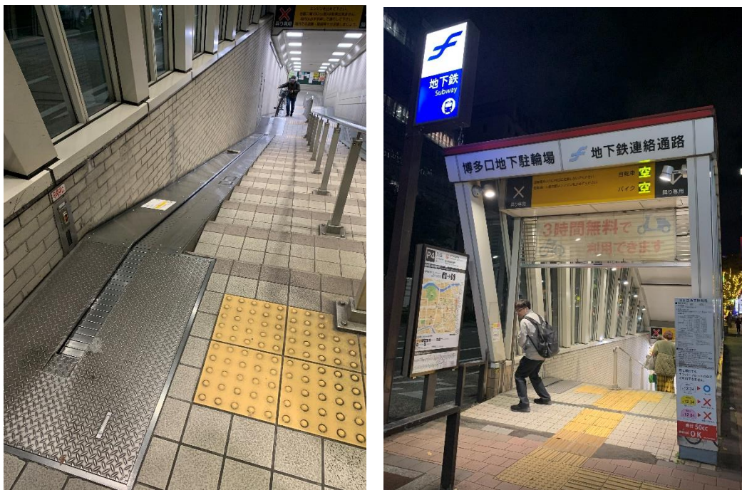
圖 115 車站出路口設置便於旅客牽引腳踏車上下樓梯之牽引道
