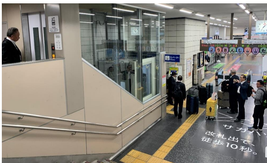
圖 110 佐賀站設置緩坡式移動客用電梯
