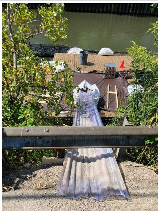
材料由河岸上停車場處以滑行道送至浮島平臺
