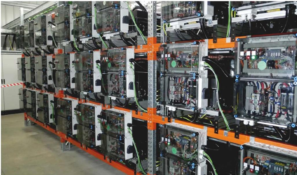
圖 4.3-7 廢舊鋰電池儲能系統
