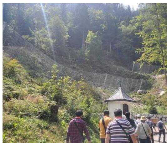
圖 4-101、山徑步道旁山坡設有防落石鋼
