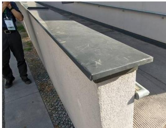
圖 4-4、混凝土牆上覆鋼板可低破壞風險
