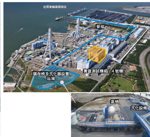
圖 22：碧南火力發電廠 20%混氨發電實證計畫(摘自本次研修課程簡報)
