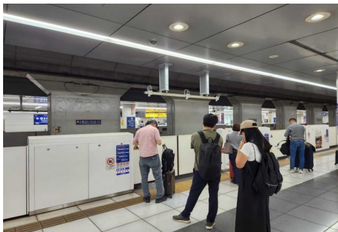
圖 61 月台門上的監視設備
