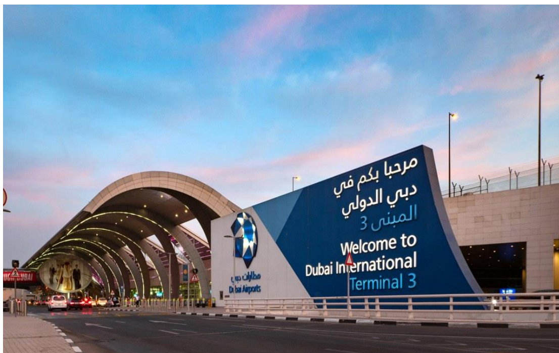
圖 30 杜拜國際機場第三航站
