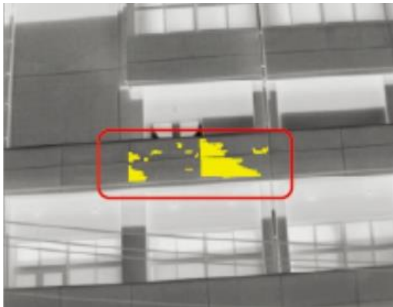
圖 32 以 AI 提取超出標準溫差的區域
