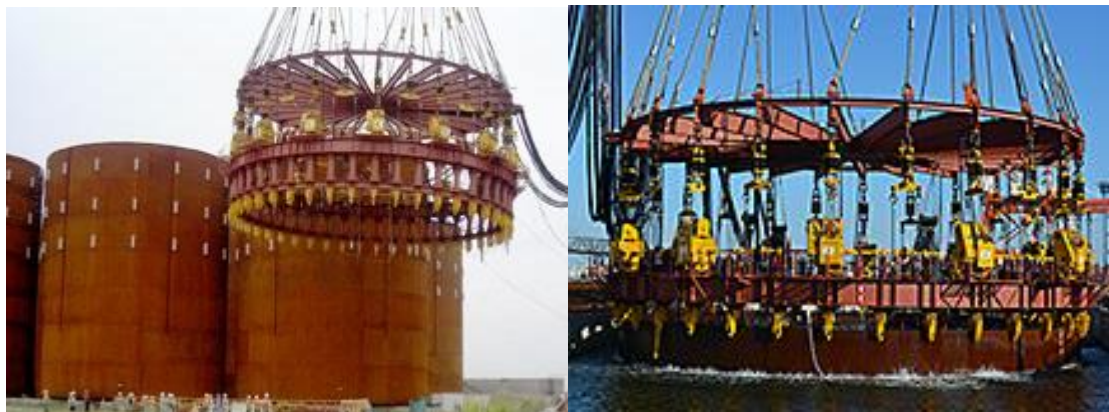
圖 10 植入式鋼板格柵工法
