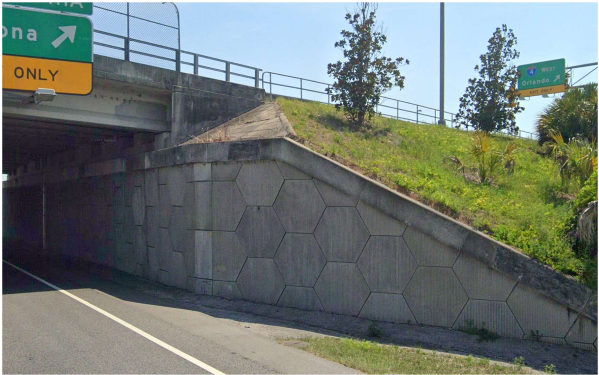
圖 六-21 SR-421州道跨越 I-4州際公路橋梁預鑄面板橋臺
