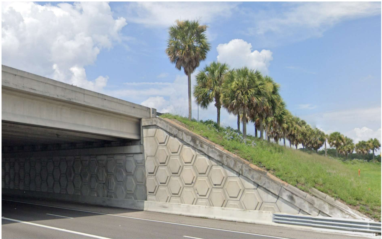
圖 六-22 W Lake Mary Blvd 跨越 I-4州際公路橋梁預鑄面板橋臺
