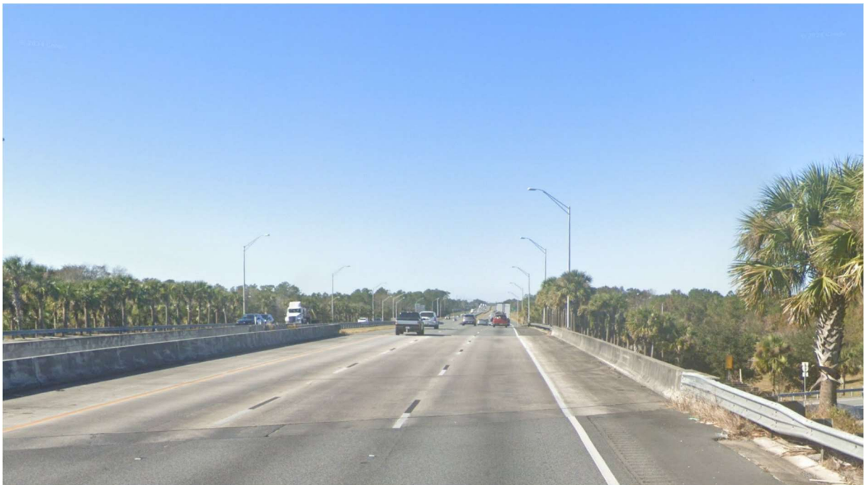
圖 六-16 I-95州際公路 AC 路面及跨越 US-1州道橋梁 RC 路面（掃橫紋）
