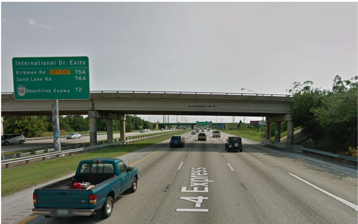
圖 六-31 I-4 Ultimate 計畫於 I-75 跨越橋-改建前(資料來源：www.google.com)
