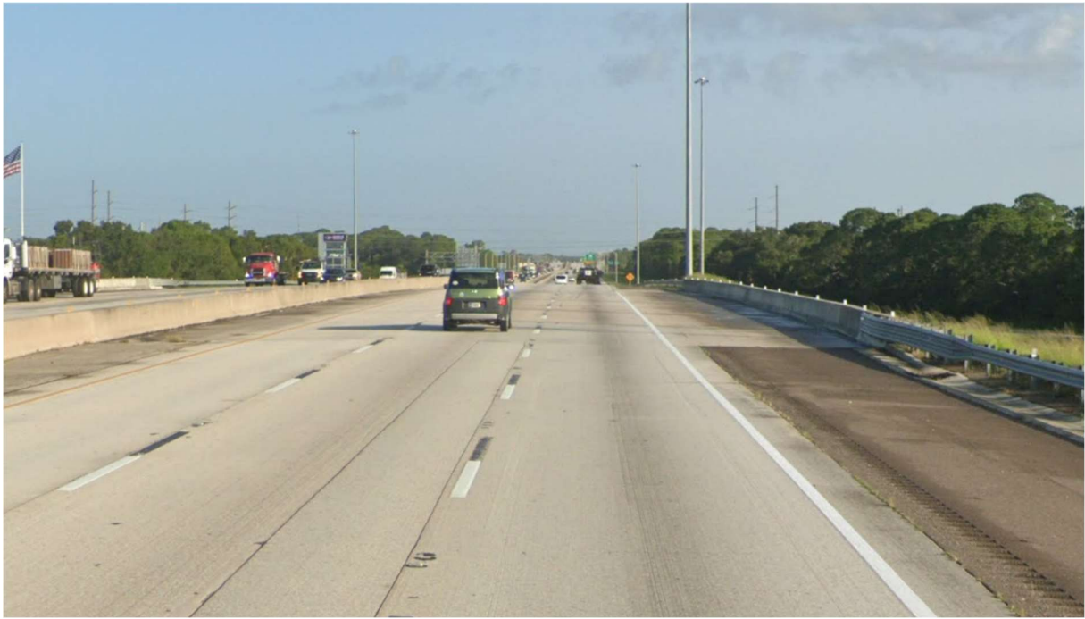
圖 六-15 I-95州際公路 RC 路面車道（掃直紋） 及跨越 SR-520州道橋梁 RC 路面（掃橫紋）
