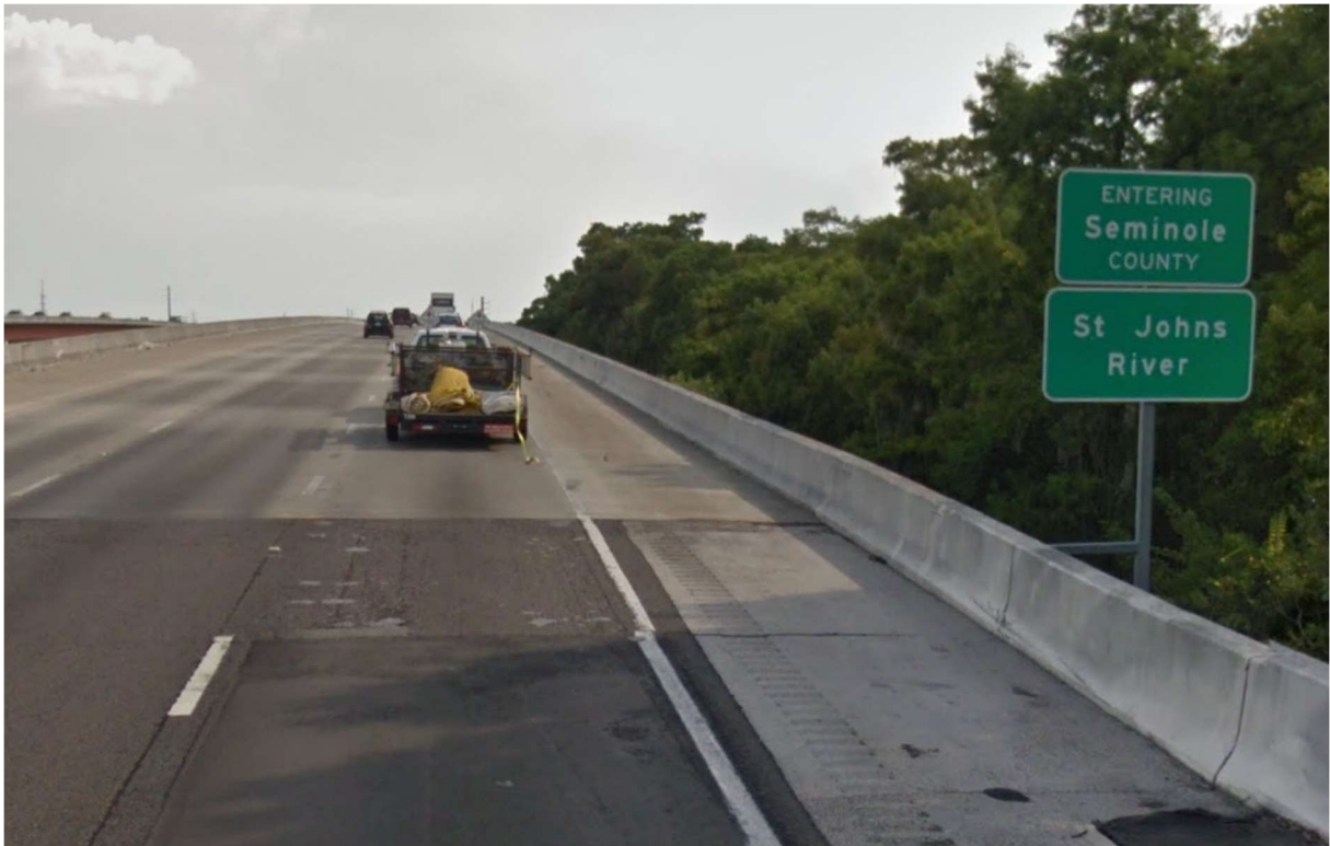
圖 六-17 I-4州際公路 AC 路面及跨越 St Johns River 橋梁 RC 路面（掃橫紋）
