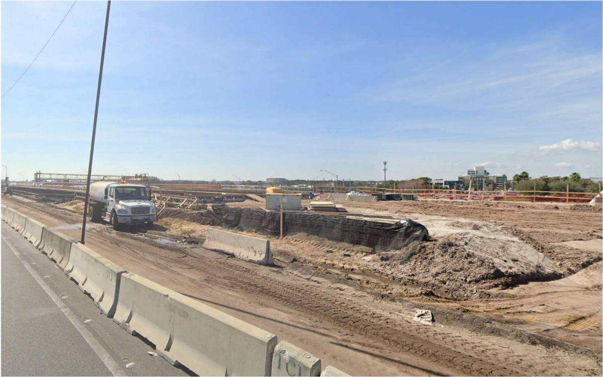
圖 六-34 I-4 BtU 計畫橋梁及道路拓寬施工
