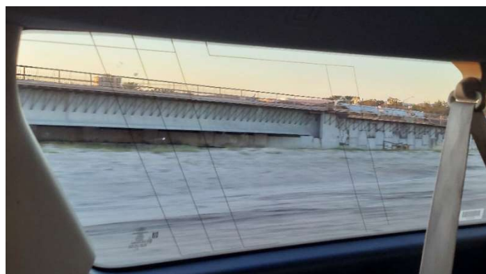
圖 六-23 I-4 BtU 計畫橋梁施工
