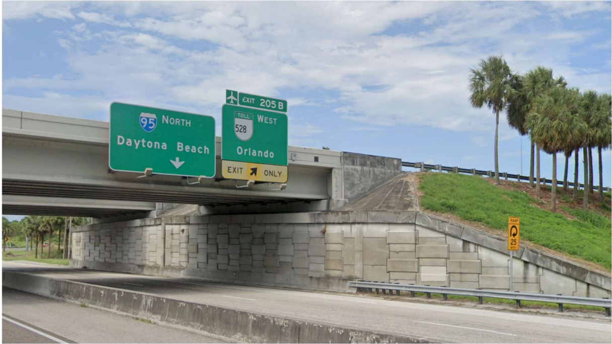
圖 六-19 SR-528州道跨越 I-95州際公路橋梁預鑄面板橋臺
