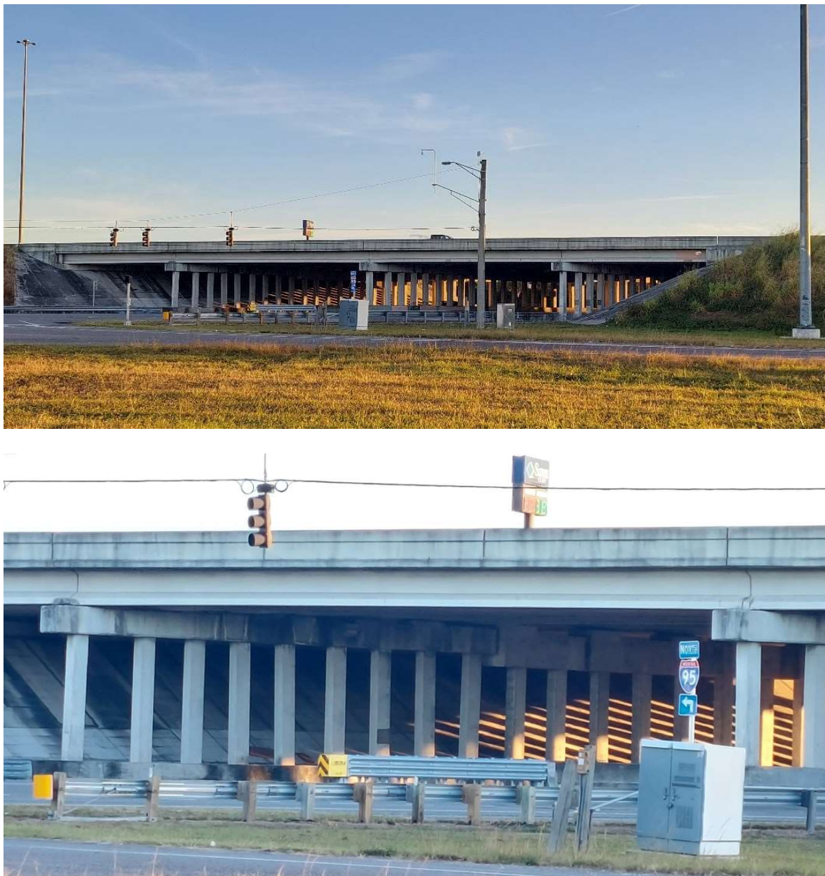
圖 六-14 I-95州際公路跨越 SR-520州道橋梁遠照及近照
