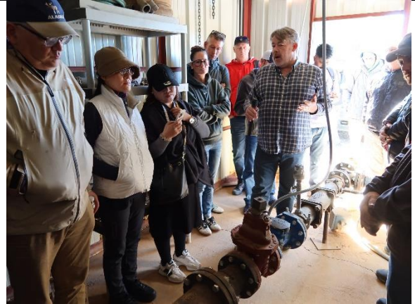
聖喬治太陽能泵系統－泵浦抽水及控制設備
