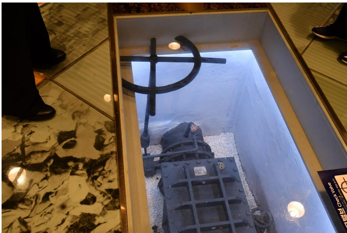
圖 86 蘆島淨水場博物館加壓室之水錘保護裝置
