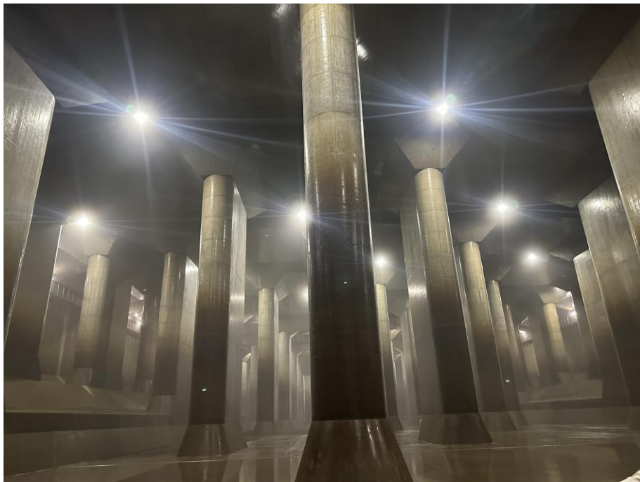
圖 46 首都圈外外圍排水道之地下蓄水池豎井實景
