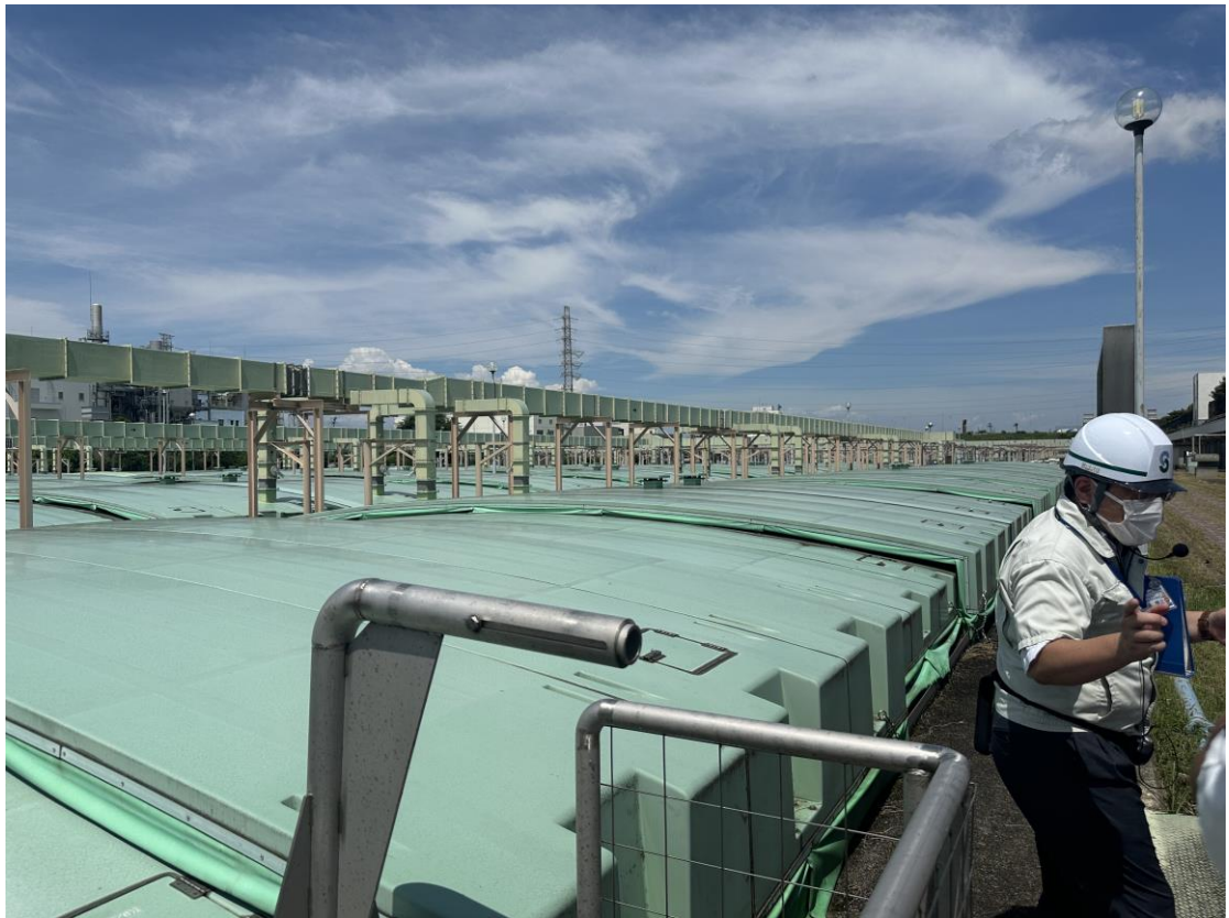
圖 44 荒川水再生中心生物處理單元皆加蓋避免異味飄散
