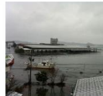
防波堤を越流した津波により浸水した荷さばき所
