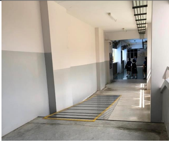
不同棟建築物連通高低差，設有無障礙坡道
