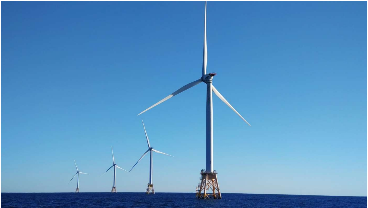
圖 4.12 由近至遠分別為 4 到 1 號風力發電機
