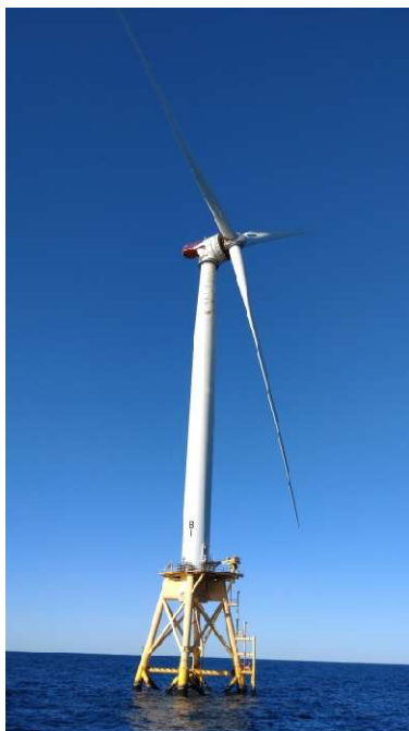
圖 4.7 風力發電機高度 180 公尺，轉子直徑 150 公尺，葉片長度 73.5 公尺。
