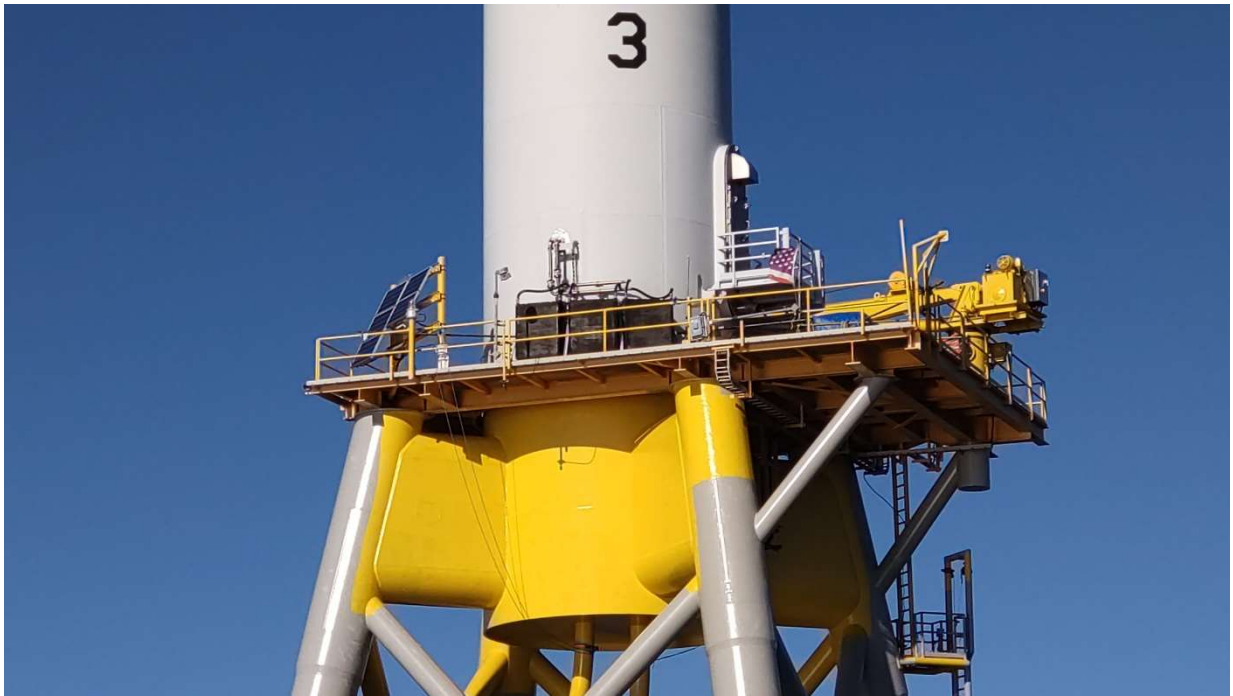
圖 4.10 特寫 3 號風力發電機的作業平台
