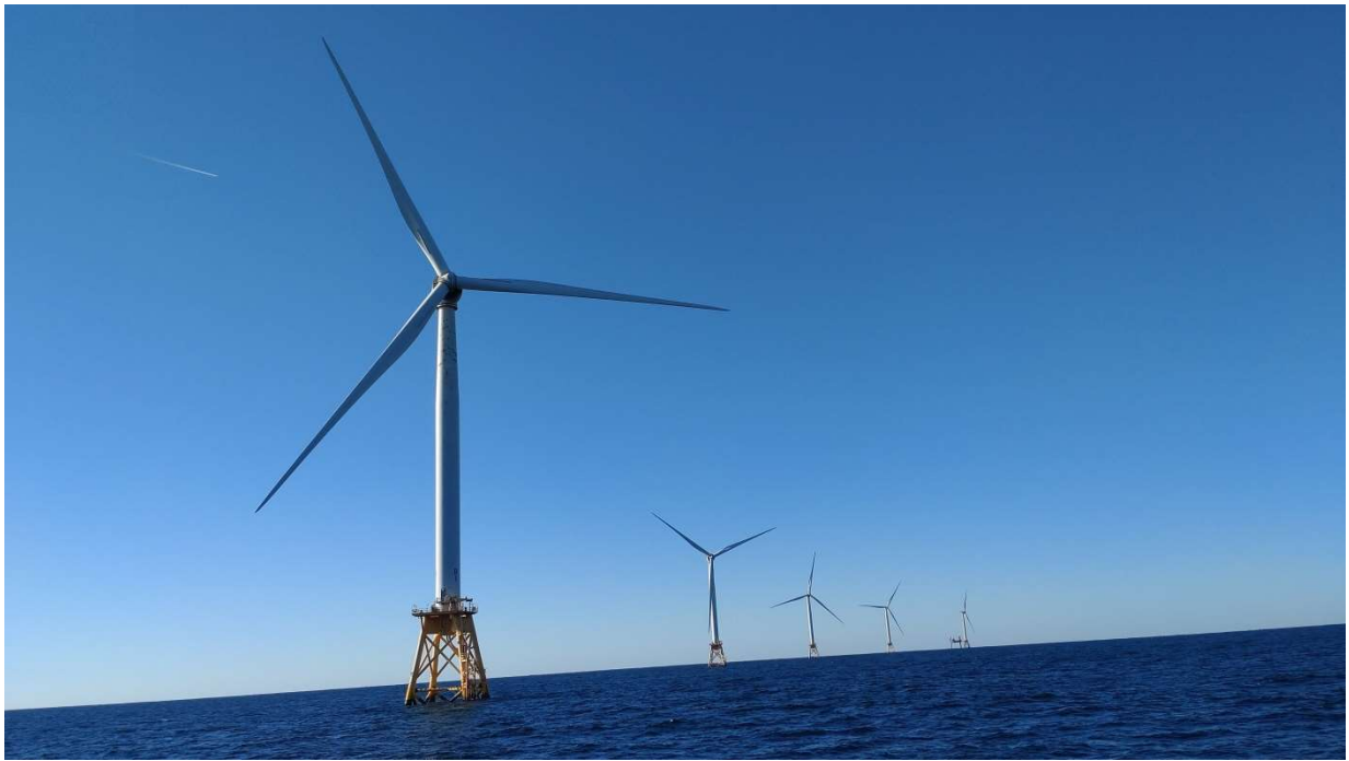
圖 4.6 由近至遠分別為 1 到 5 號風力發電機，每部機組間距 830 公尺。
