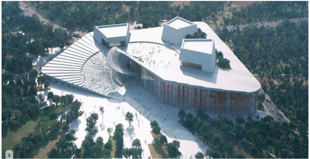
圖 6 上海大歌劇院全景
