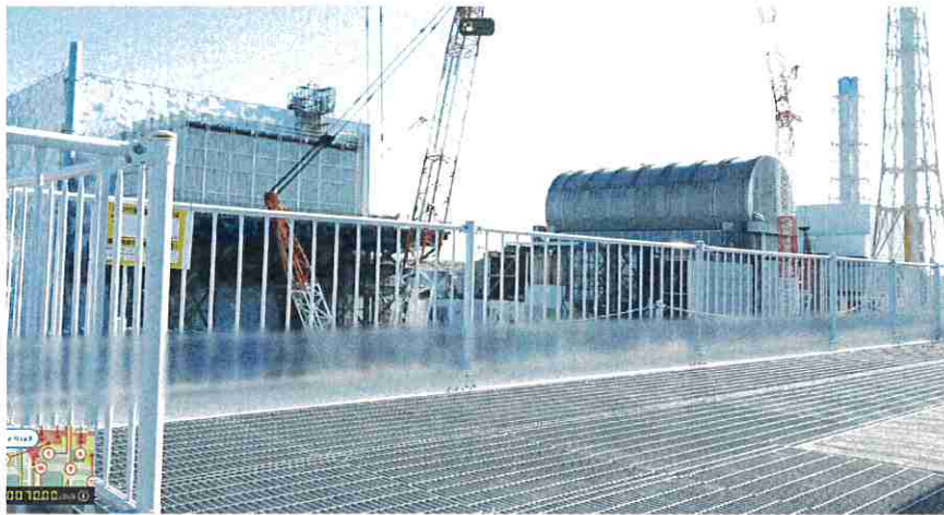
距機組約 100 米之 高架參觀平台
