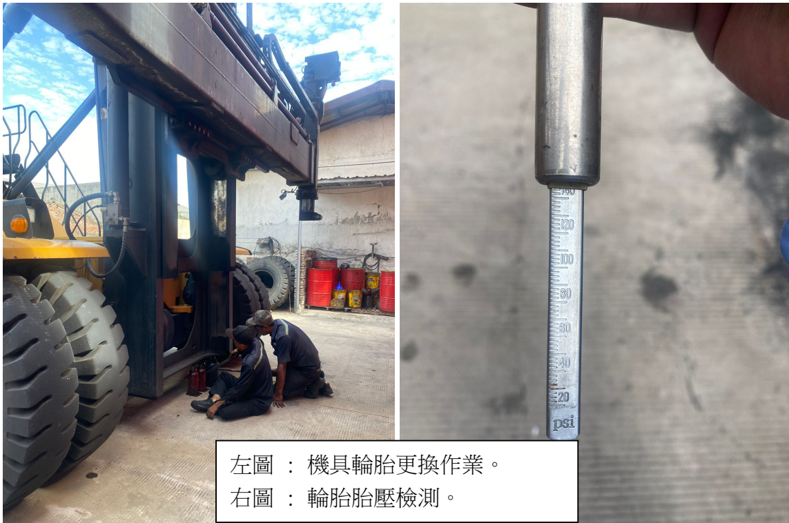
左中圖：機具散熱器檢測。 右圖：機具散熱器更換。
