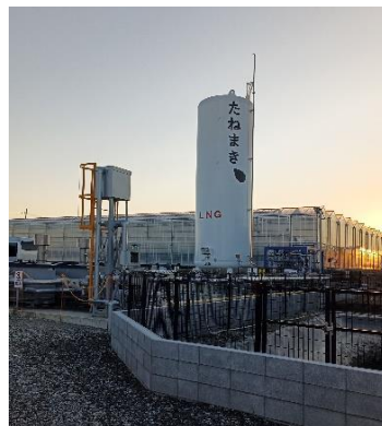
株式会社たねまき常総（TANEMAKI JOSO 株式会社）三聯供能系統(使用液化天然氣作為能源)，燃燒能源進行發電，發電時產生的熱用於供暖，二氧化碳則用於植物的種植。
