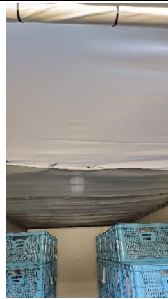
小型組合式冷藏庫於庫內上方加設不同網目大小的網子，改變冷風方向。
