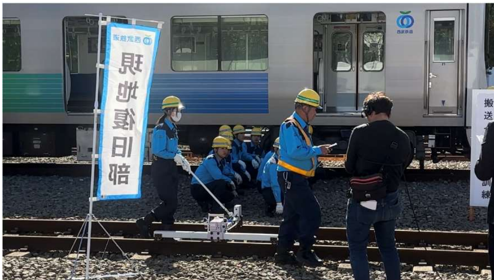
圖 15 工務人員測量軌距
