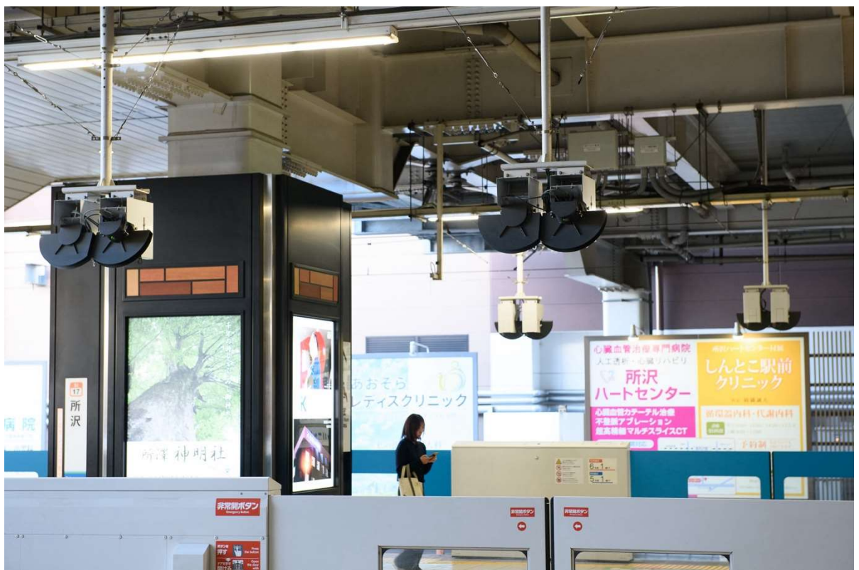
圖 37 所澤站月台門列車停車位置偵測器（1）
