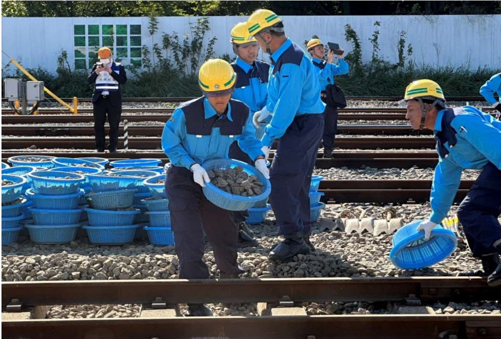
圖 14 工務人員接力補碴
