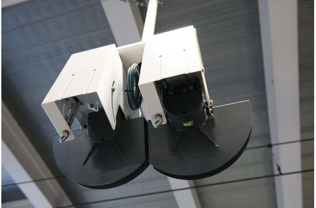
圖 38 所澤站月台門開關狀態顯示器
