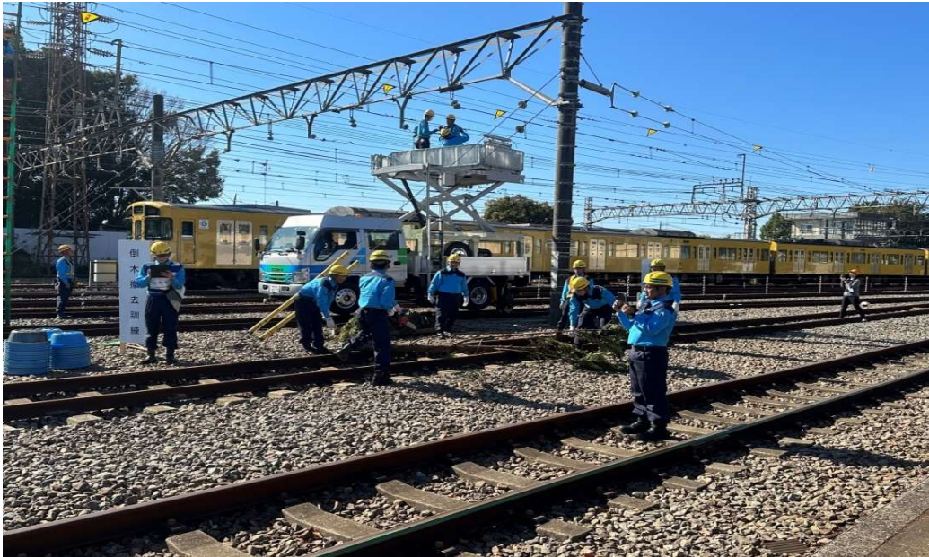
圖 11 路軌兩用車駛入路線並以升降平台進行電車線搶修
