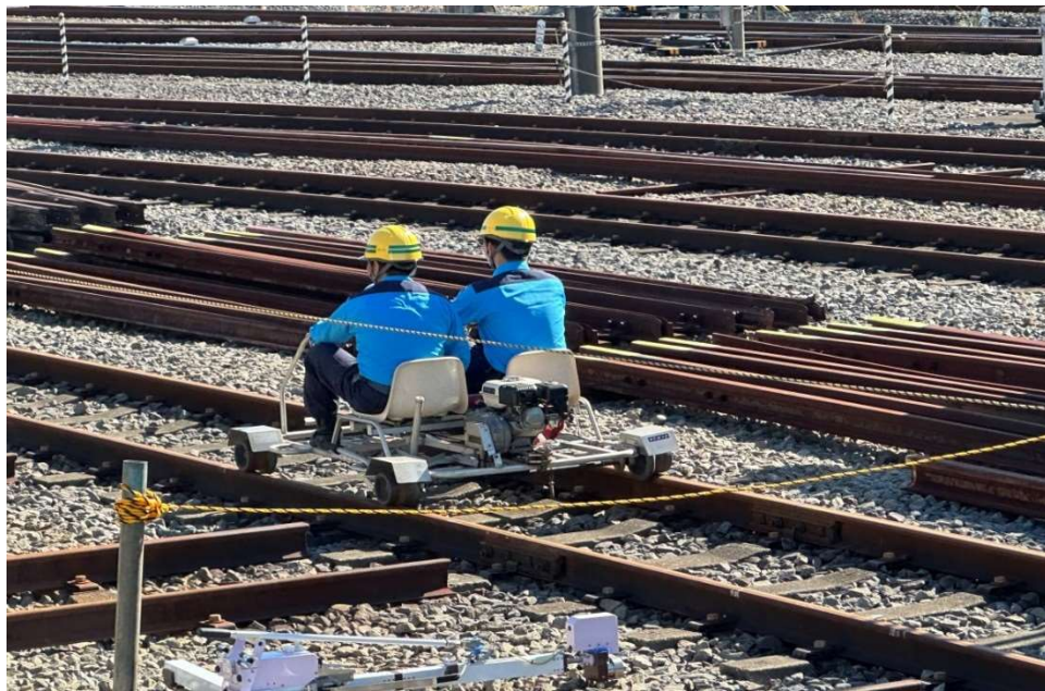
圖 13 工務人員駕駛輕型巡軌車快速前往現場進行搶修
