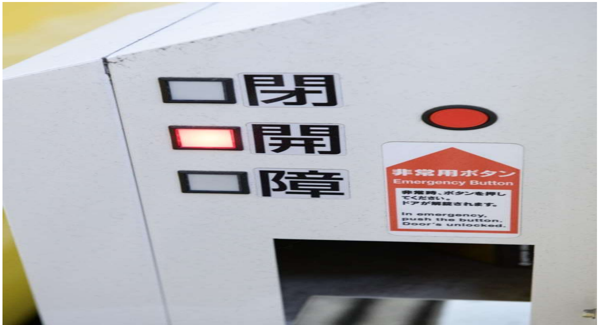
圖 39 所澤站月台門列車停車位置偵測器 (2)
