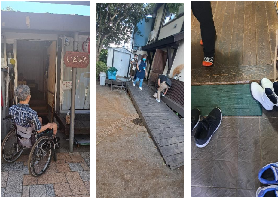
圖 70 左中右 設坡道及移動式消坡板提供使用輪椅長輩通行
