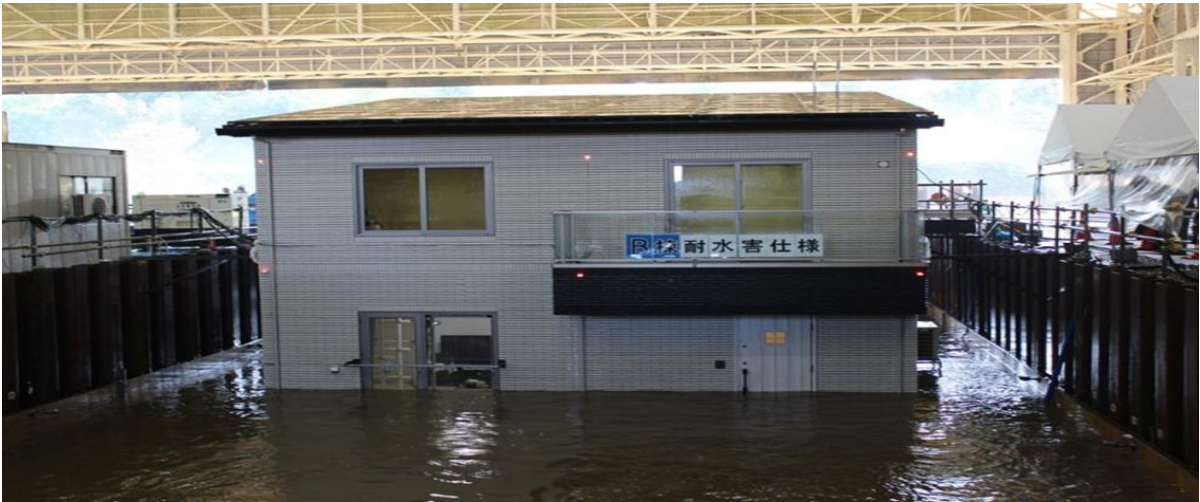
圖 6 日本一條工務店研發防洪住宅於大型水槽進行淹水測試
