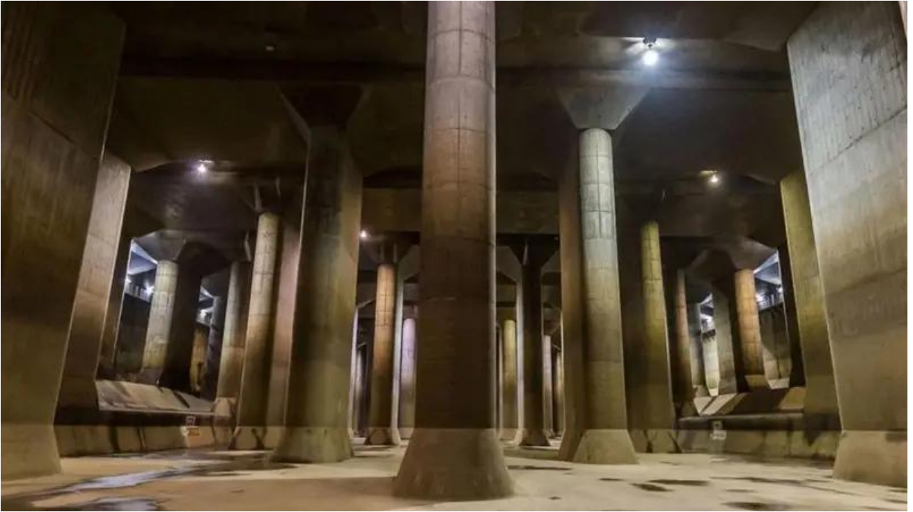
圖 2 日本首都圈外廓放水路工程之地下滯洪池（號稱「東京地下神殿」）
