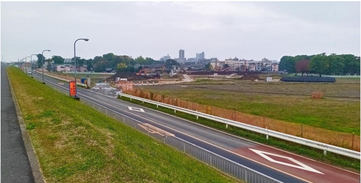
圖 13 江戶川區篠崎公園地區高台營造填土工程施工現況
