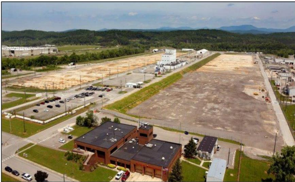
圖 5. K-25 場地拆除後
