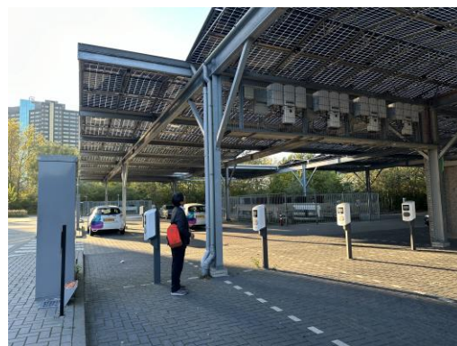
停車位 100% 設充電樁，屋頂滿鋪太陽能版
