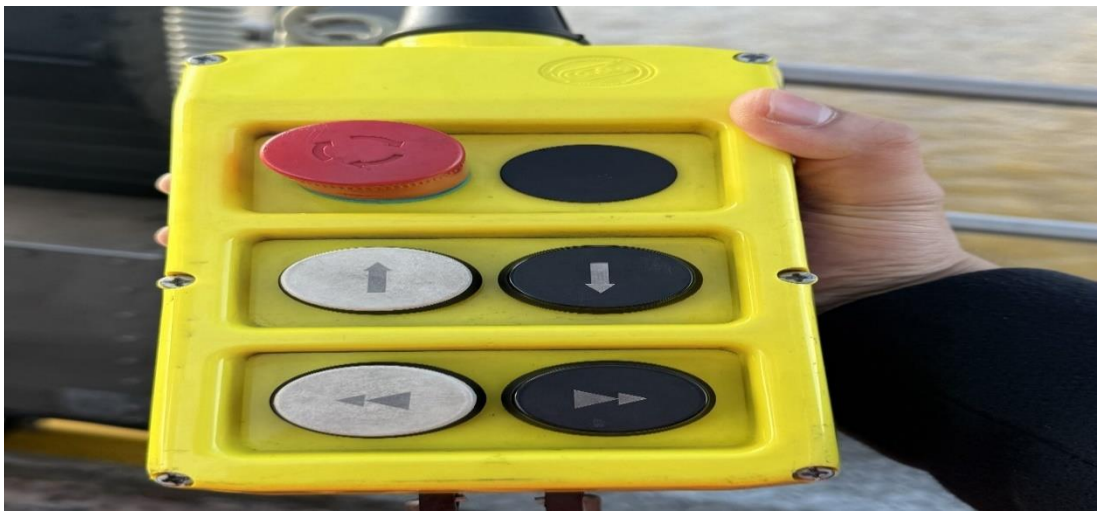
【圖 12、CTB 碼頭移動式岸電設施遙控器，操作介面簡易】
