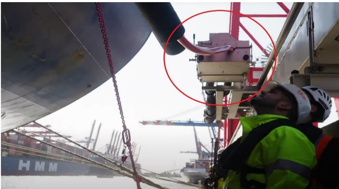
【圖 13、船上電纜接上岸電箱後，岸電箱將關閉並移離地面】
