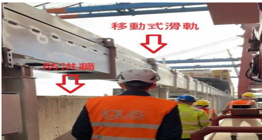
【圖 15、IGUS 公司因應 CTH 碼頭特性將移動式滑軌架設於防洪牆上】
