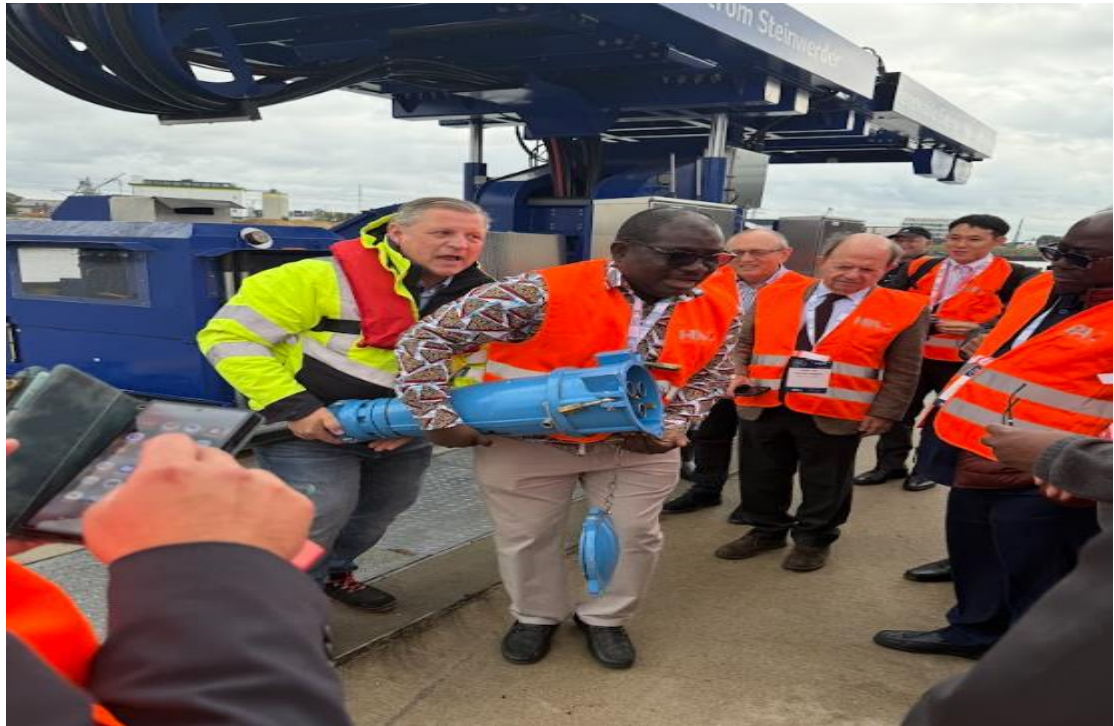
【圖 11、岸電電纜及接頭沉重，如需較長距離搬運需多名人員共同完成】
