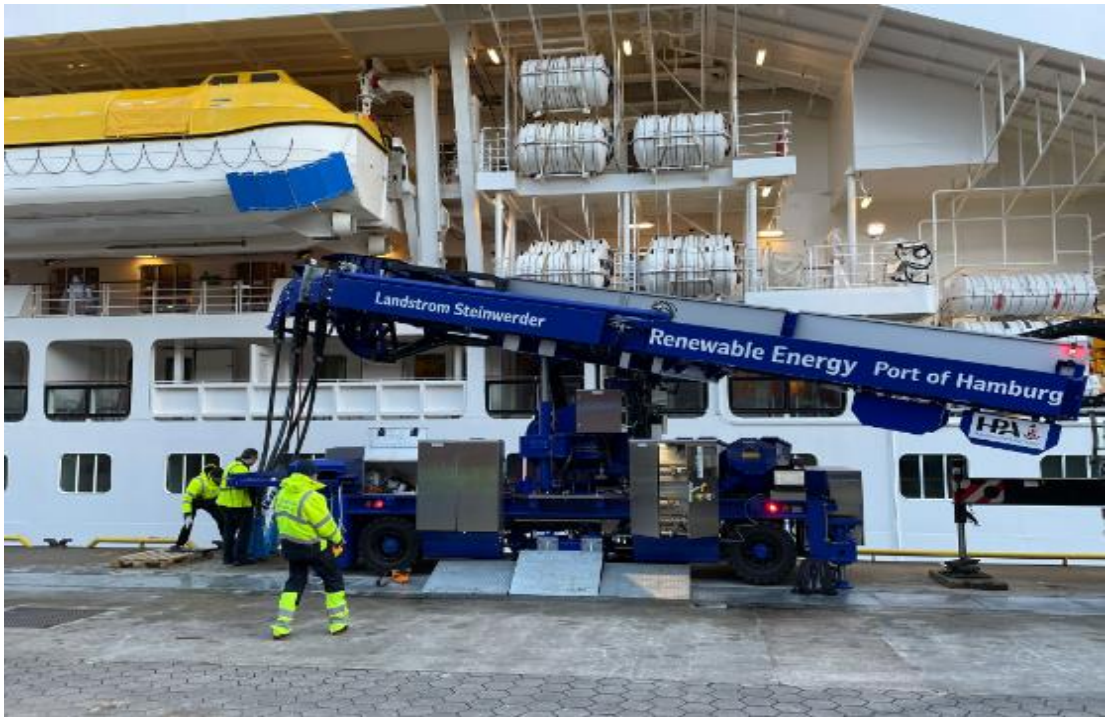
【圖 10、電纜車系統可上下移動，避免電纜因潮差變化受到拉扯或脫落】
