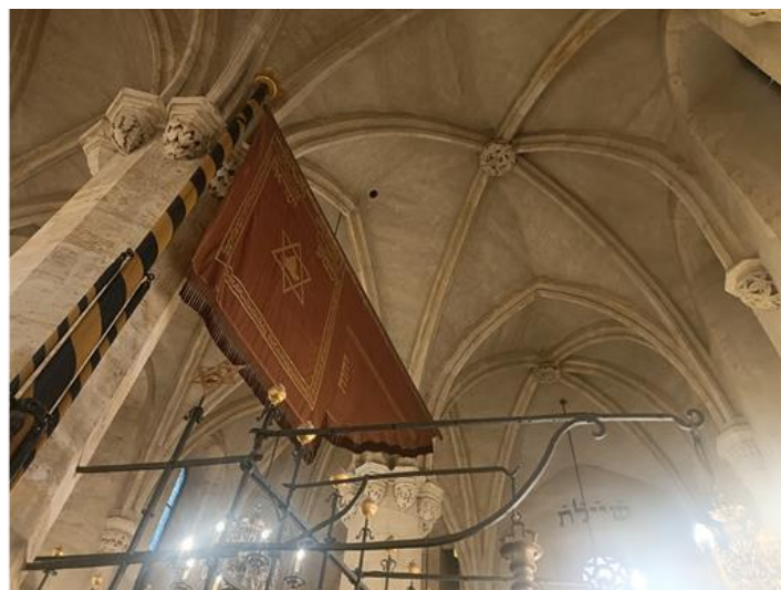
圖說（左）：新舊猶太教堂屋頂以數個拱形結構組成
