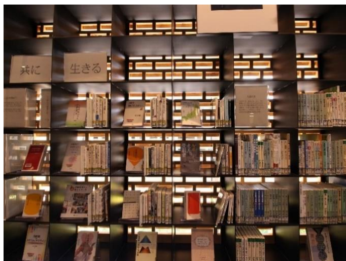
空心磚的外牆讓光線可以增加室內照度
