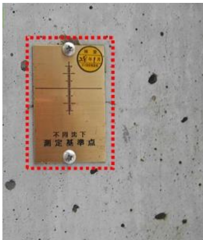
圖 3-18、儲槽沉降狀況
