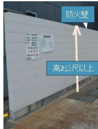
圖 3-31、高壓氣體設備與場地邊界間防火牆
