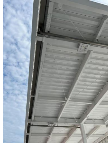
圖 3-29、加氫機上方的屋頂結構 (採傾斜及通透設計)
