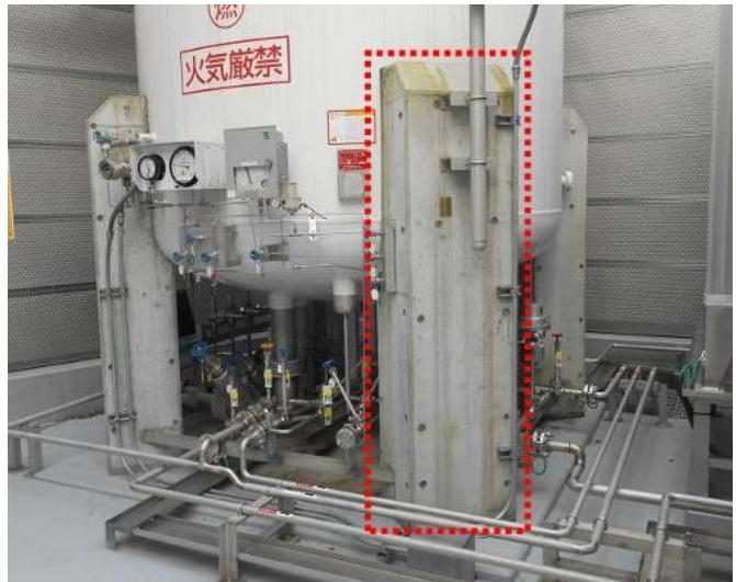
圖 3-25、防止儲槽和支柱溫度上升措施
