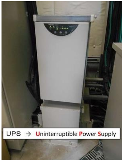
圖 3-24、緊急電源的確保
