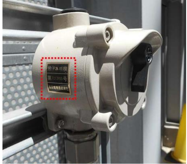
圖 3-23、電氣設備的防爆
