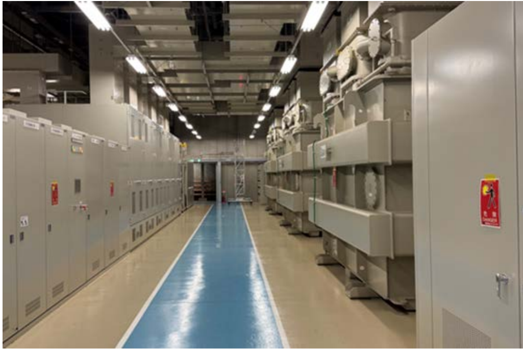
圖 17：變頻式機組冷卻設備
