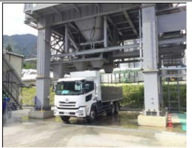
B. 混凝土材料裝車
