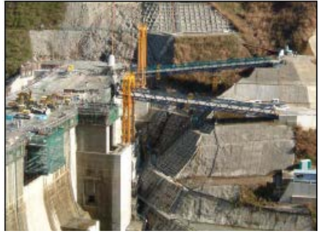
B. 混凝土材料運送至大壩施工面
