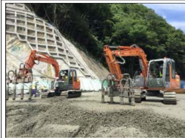
E. 以振動機具搗實混凝土
