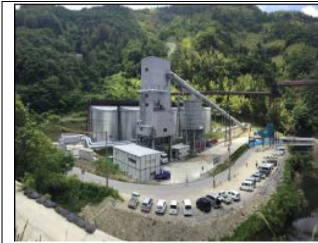
A. 混凝土拌合場
