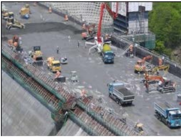
C. 大壩填築面之施工機具
