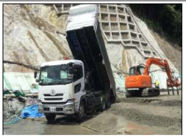
D. 混凝土材料傾卸
