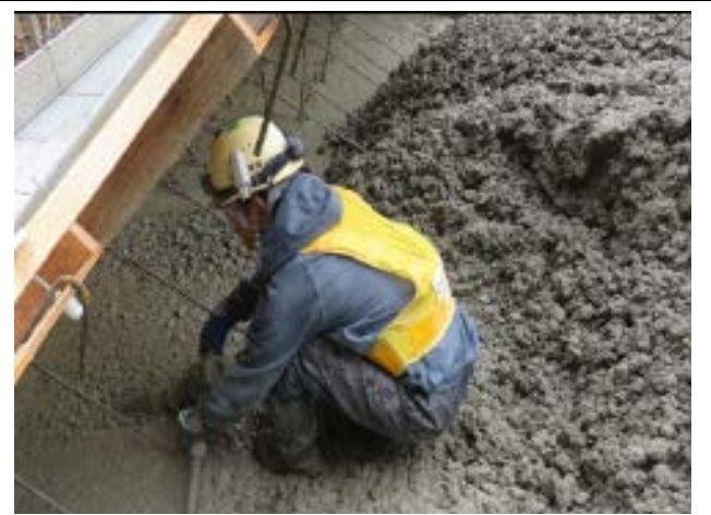
F. 機具無法搗實部分採人工搗實混凝土
