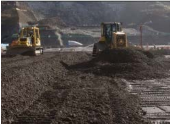
E. 推土機整平混凝土
