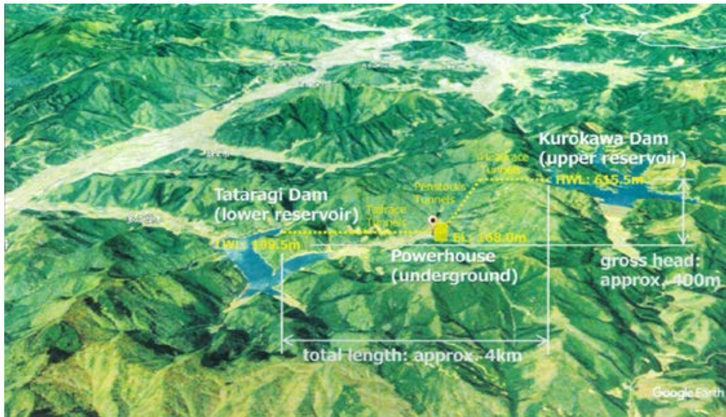
圖 9：奧多多良木電廠俯視圖(1)
