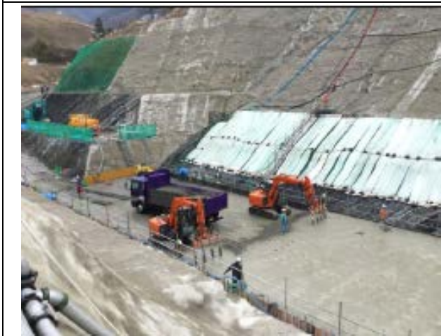
C. 混凝土材料運送至大壩施工面
