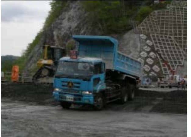
D. 混凝土材料傾卸
