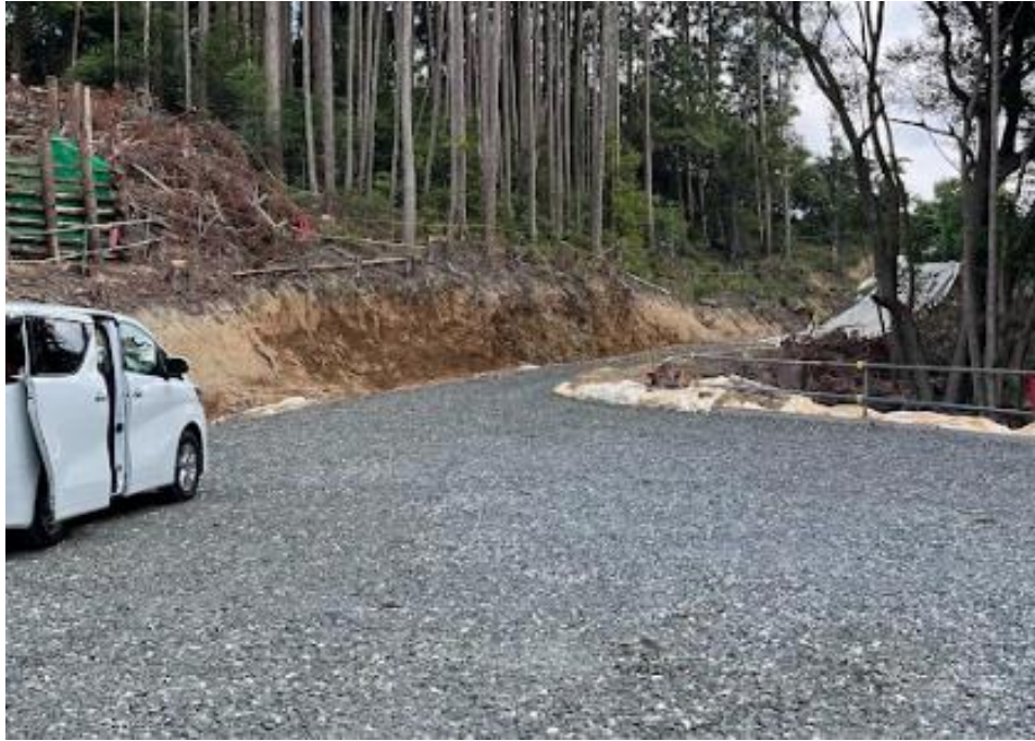
圖 2-7 #34 鐵塔工區進出通道
