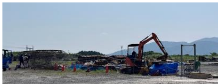
圖 2-4 物料儲置場及鋼筋籠加工廠
