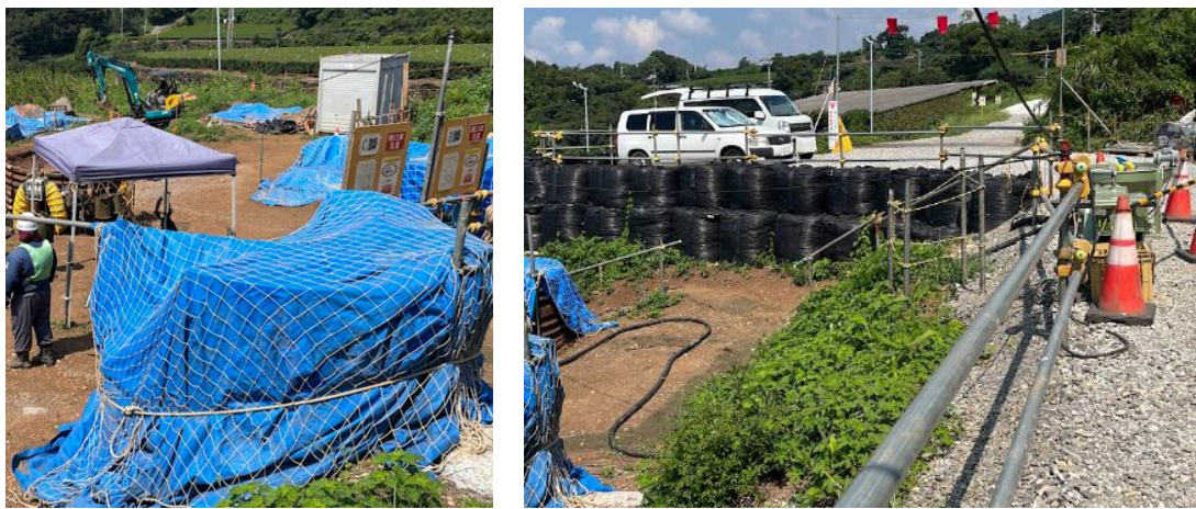
圖 2-22 #56 塔基工區管理作為
