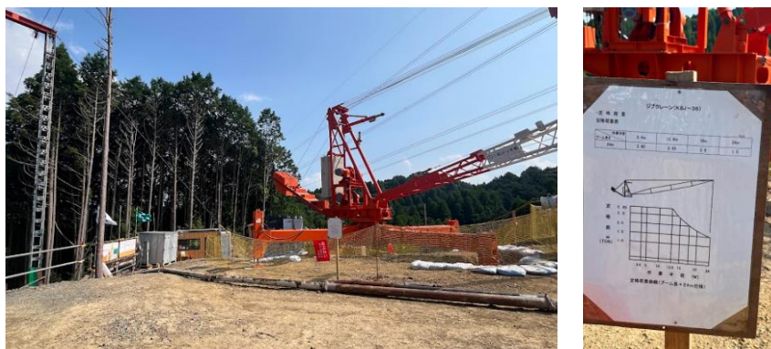
圖 2-17 #42 塔基工區組裝式吊裝機及荷重表
