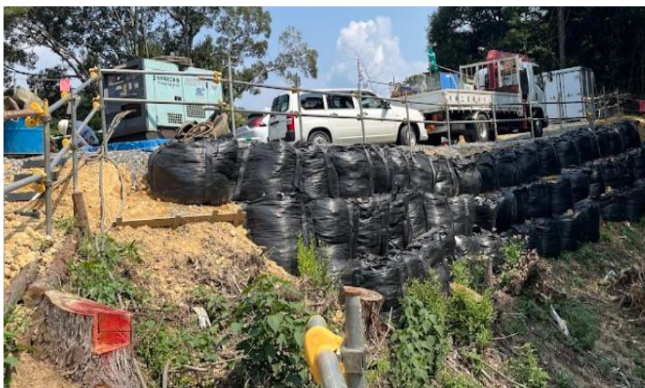
圖 2-14 原土太空包為整地材料
