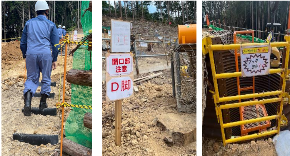
圖 2-8 #34 鐵塔工區安全管理措施
