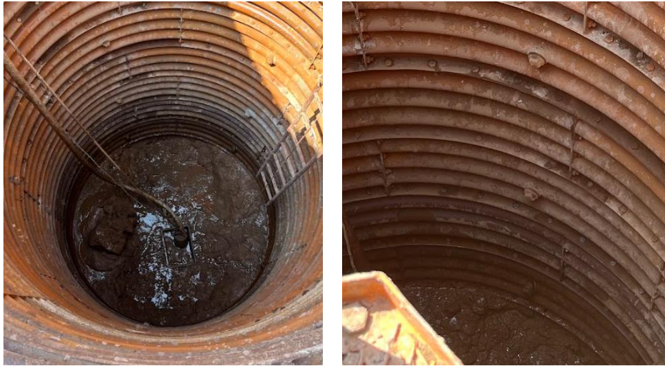
圖 2-23 #56 D 腳湧水情形
