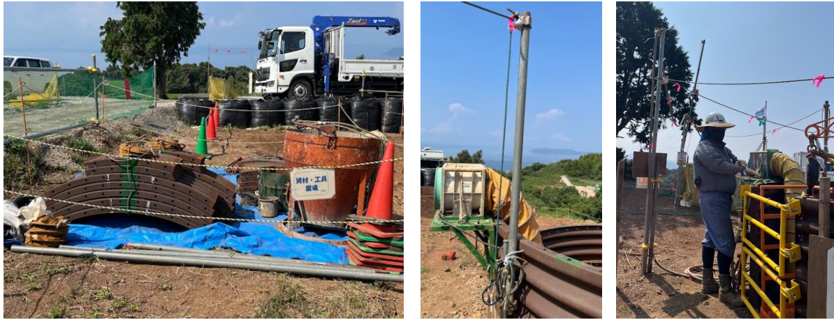
圖 2-21 #55 塔基工區管理作為
