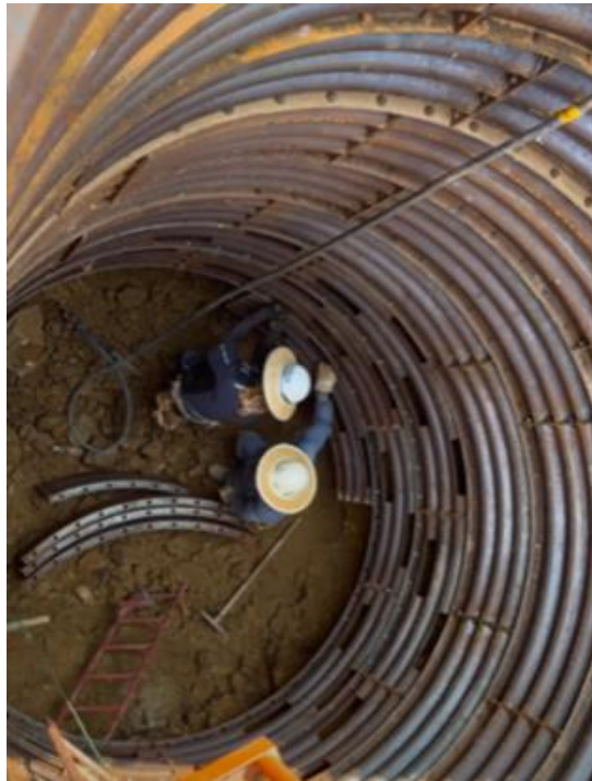
圖 2-10 開口式浪板組裝作業
