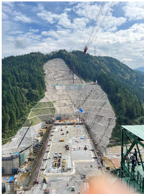
圖 3.1.5-6 足羽川水壩壩體施工情形
