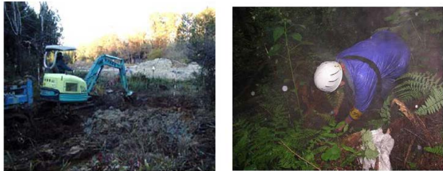
圖 3.1.2-10 周圍表土的收集(左圖)、重要樹種的移植(右圖)
