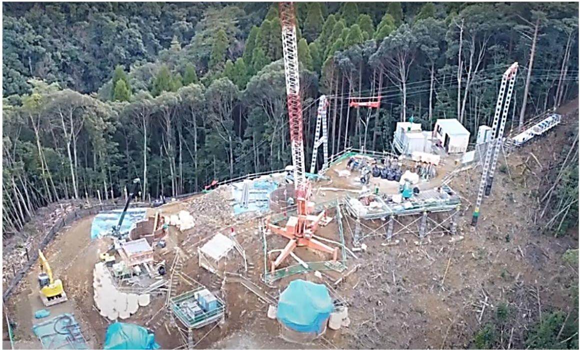
圖 3-3 塔基工程工區配置示意圖
