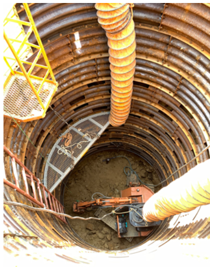
圖 2-14 坑內動力挖掘機具
