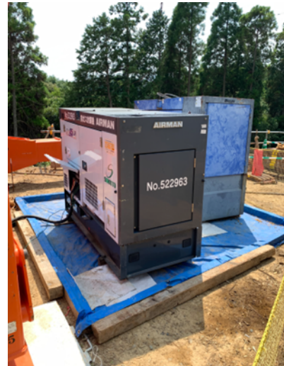
圖 2-32 用油機具下方鋪設帆布
