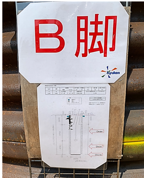
圖 2-24 基礎開挖指示牌
