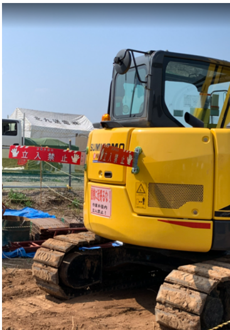
圖 3-37 挖土機裝設禁止進入警示條
