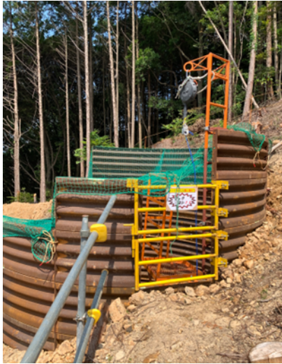
圖 2-25 基坑開口固定門
