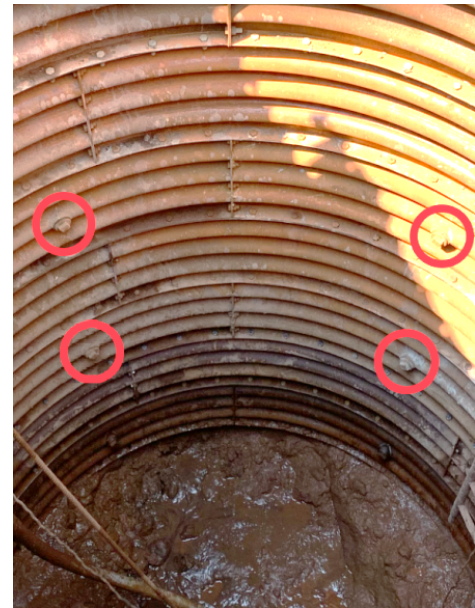
圖 3-5 背填灌漿示意圖
