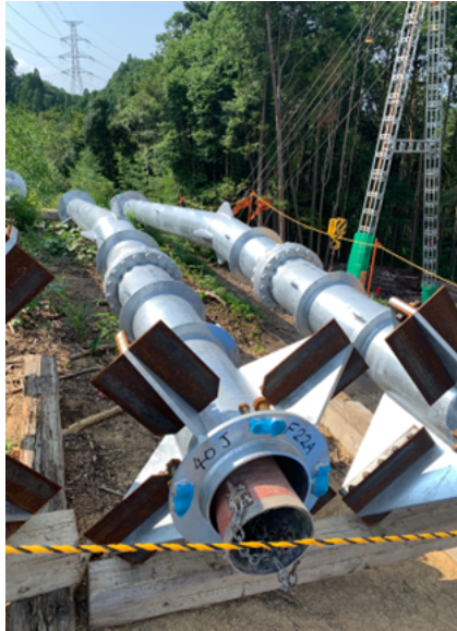
圖 2-13 圓形鋼管主柱材示意圖
