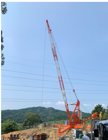
圖 2-17 大型吊掛機具
