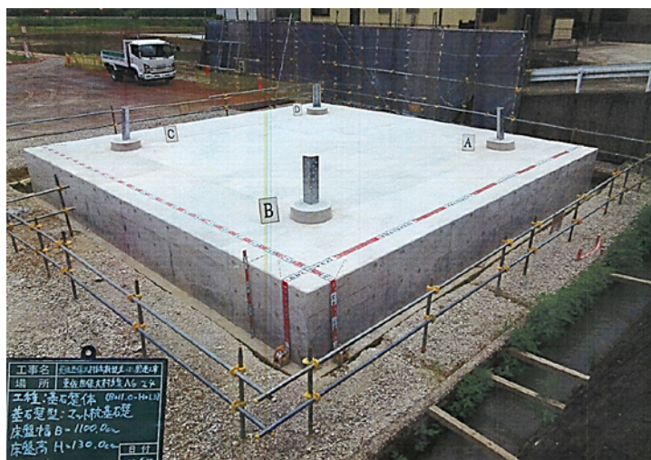
圖 2-12 筏式基礎完成示意圖
