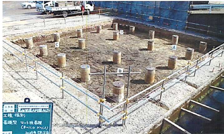
圖 2-11 筏式基礎群樁施作示意圖
