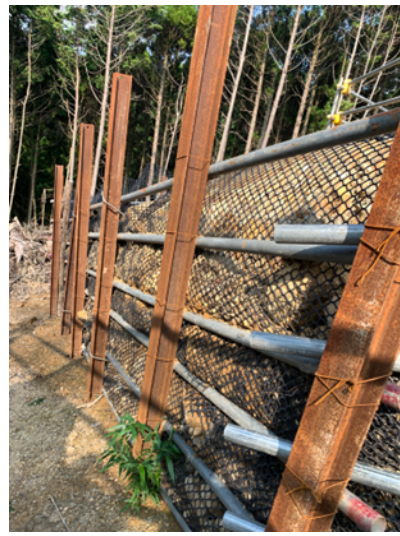
圖 2-20 鋼軌樁擋土
