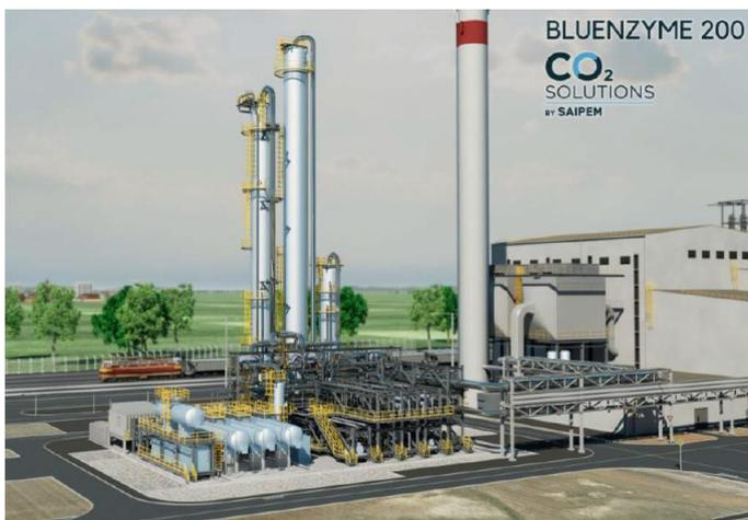
圖表 27 賽班套裝式碳捕捉設備示意
