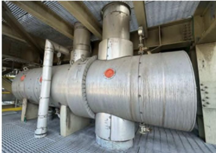
圖 10. 安裝於完成改善機組之 MGGH 熱媒加熱器
