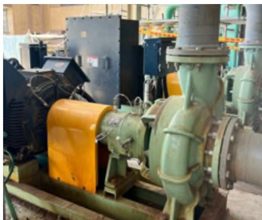
圖 9. 安裝於完成改善機組之 MGGH 熱媒循環泵
