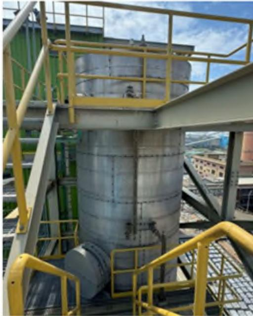
圖 11. 安裝於完成改善機組之 MGGH 熱媒槽
