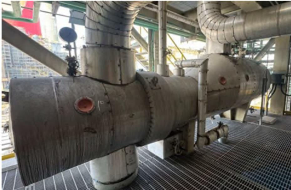
圖 12. 安裝於完成改善機組之 MGGH 附冷卻器之熱媒加熱器排水槽
