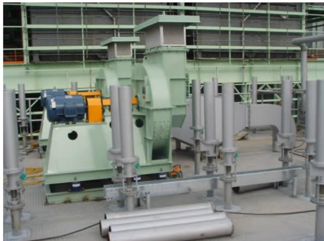
圖 37. 鼓風機及加熱系統
