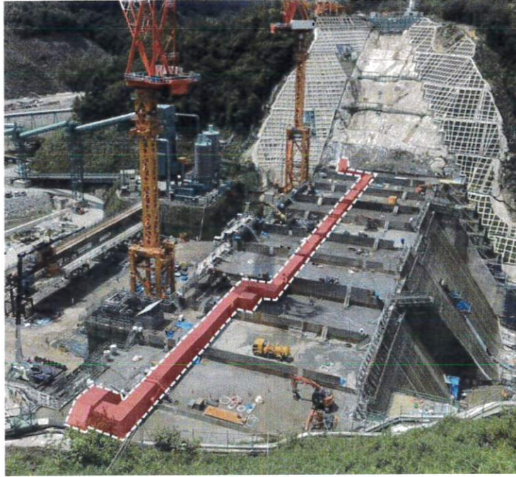
圖 9 全預鑄檢查廊道(虛線部分)
