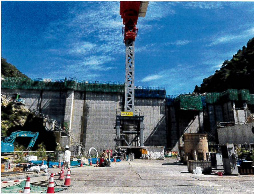
圖 16 吉野瀨川壩施工照片 (上游側)
