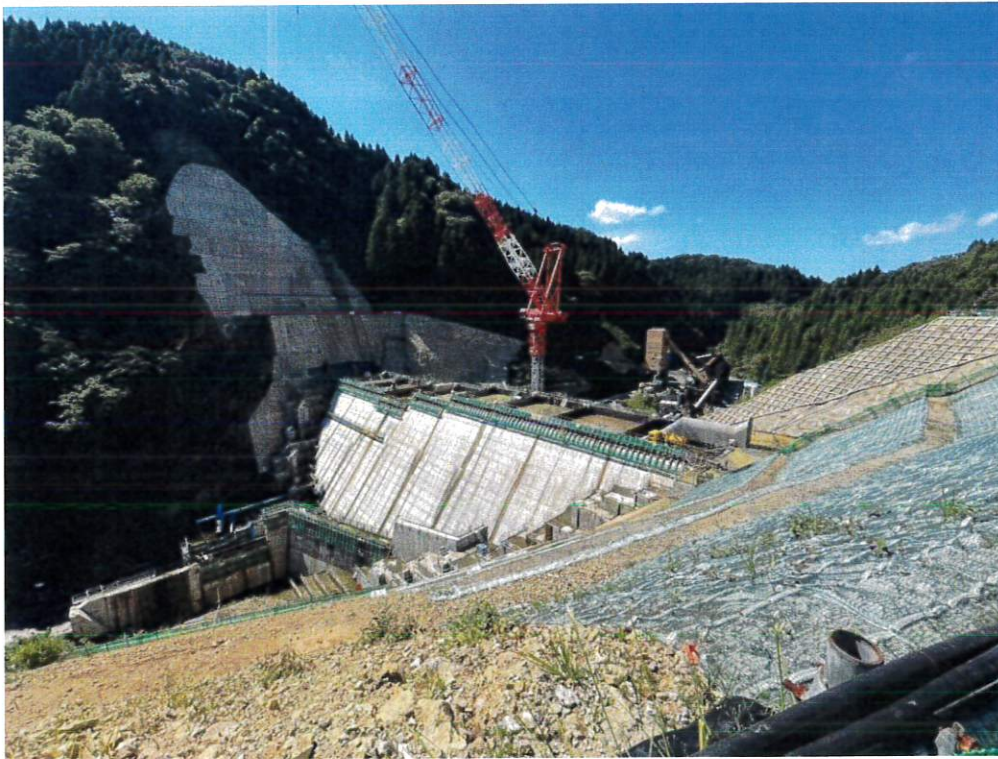
圖 15 吉野瀨川壩施工照片 (下游側)
