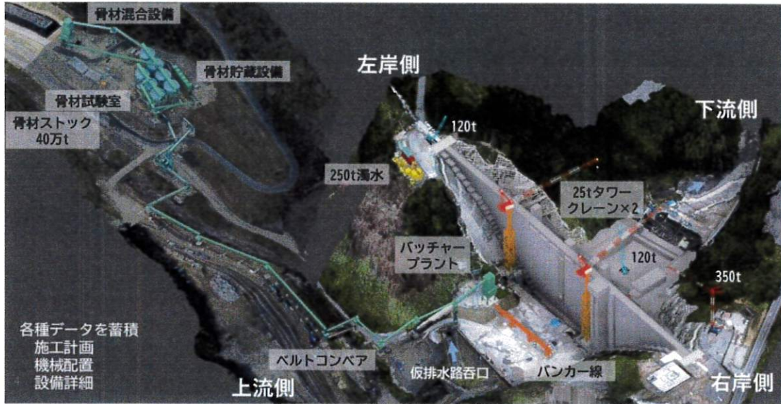
圖 7 川上大壩的設備配置圖
