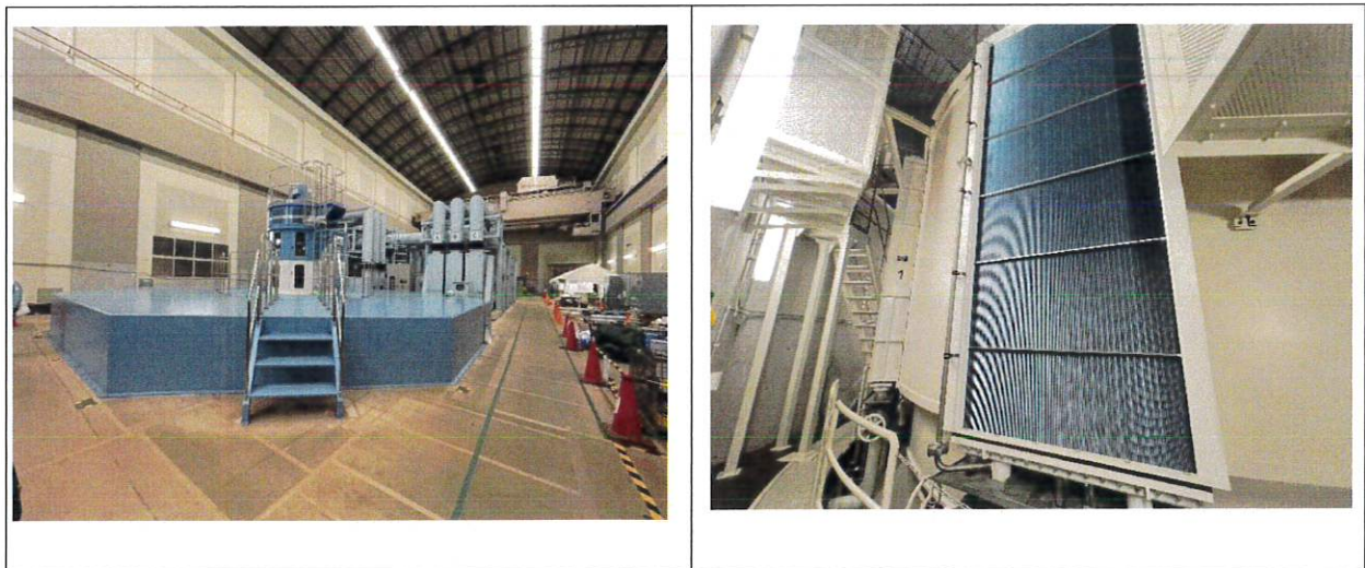
圖 4 發電電動機
