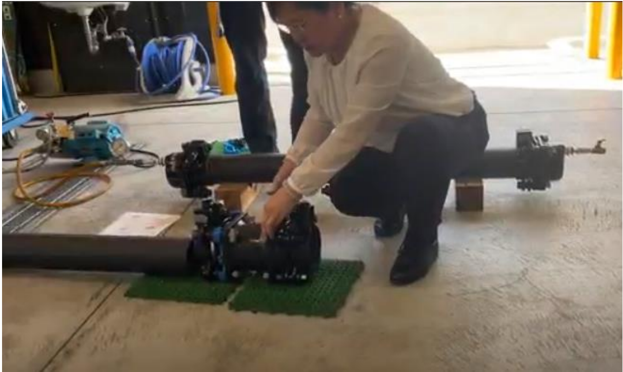
圖 3.6.5 大、小口徑快速接頭產品及安裝示範
