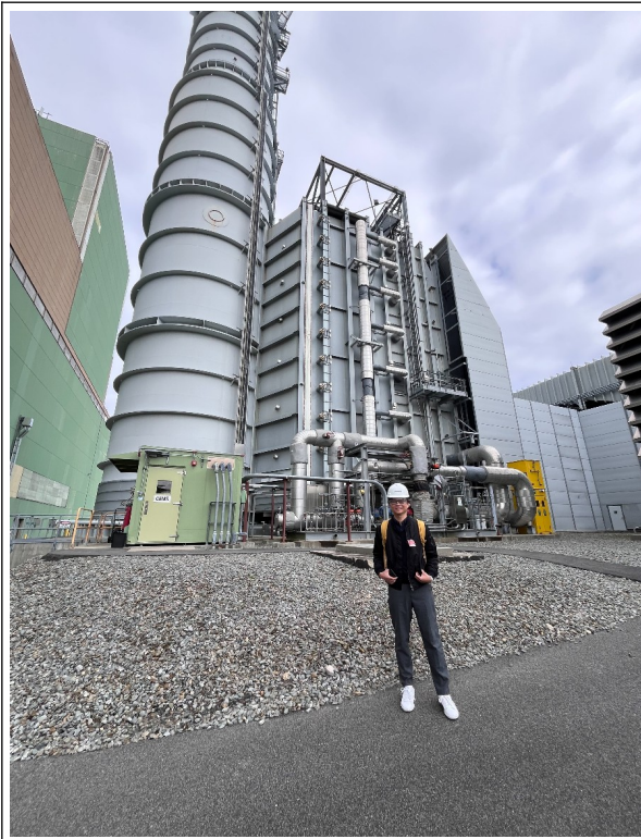
2019年完成的燃氣機組
