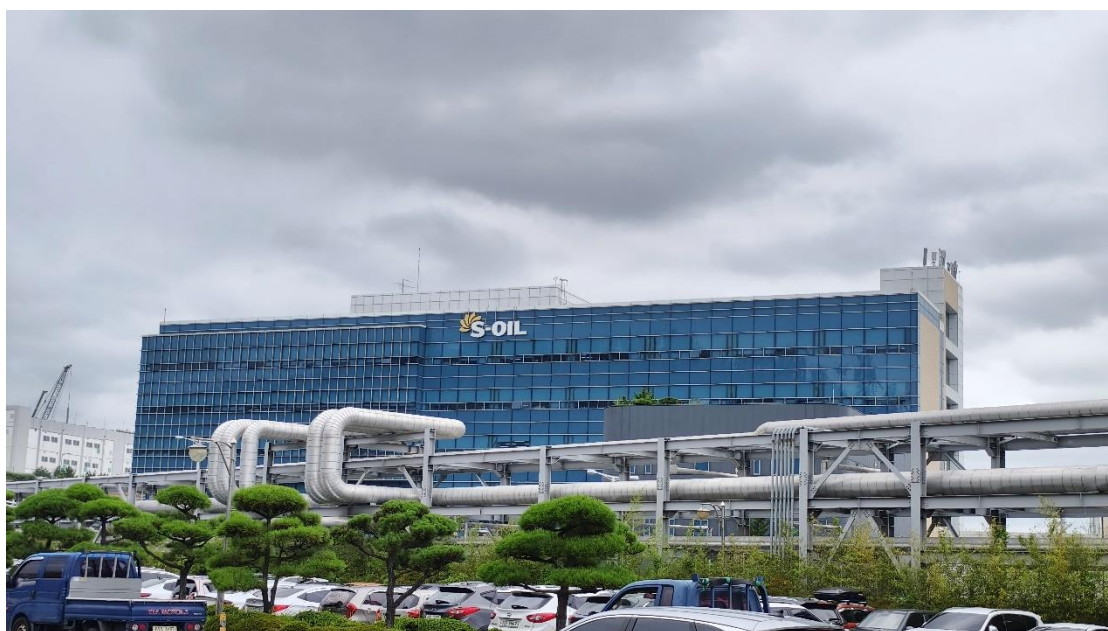
圖 3-3 S-Oil 煉油廠外拍攝行政大樓及管架
