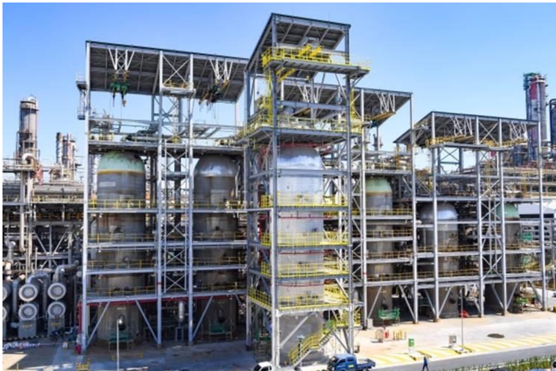
圖 3-2 S-Oil RDS 工場反應器、頂棚與吊車
