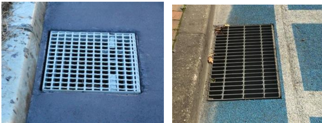
圖2-8-3 邊溝排水溝蓋型式
