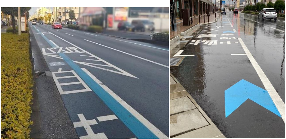
圖2-8-7 公車站與卸貨區相關標誌標線設置
