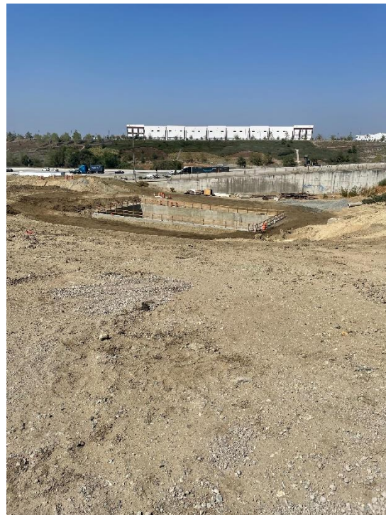
Grand Avenue 東入環道施工(57/60 Freeway Confluence Construction )
