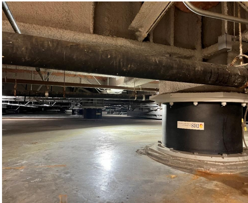
圖二十五 LARTMC 大樓基礎抗震系統
