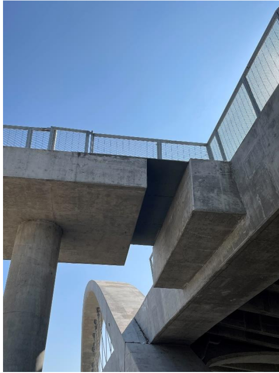
人行自行車道與主橋銜接處伸縮縫(Sixth Street Viaduct)
