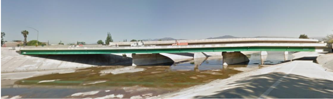
圖二 Rio Houdo Busway Bridge
