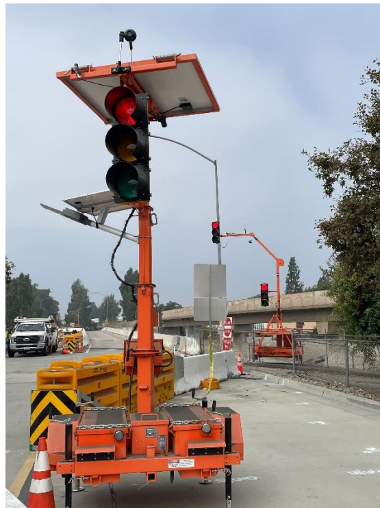
移動式號誌及緩撞設施
