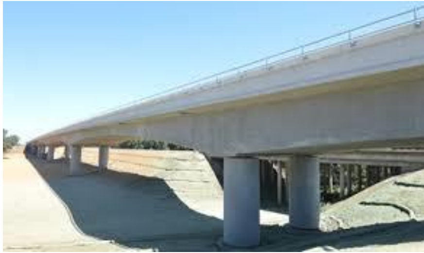
照片二 混凝土箱型梁橋
