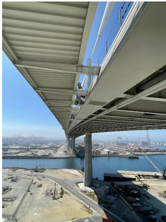
鋼床板橋面及自行車道(長灘國際門戶大橋)
