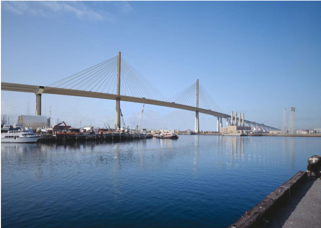
圖十六 長灘國際門戶大橋(Long Beach International Gateway bridge)
