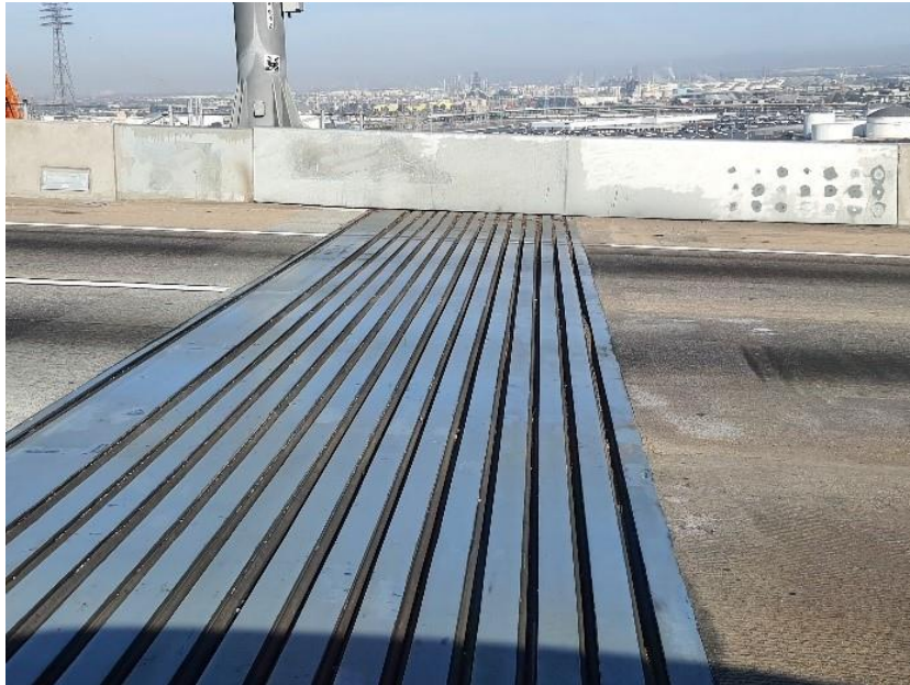
主橋及引橋銜接處大型模組伸縮縫(長灘國際門戶大橋)
