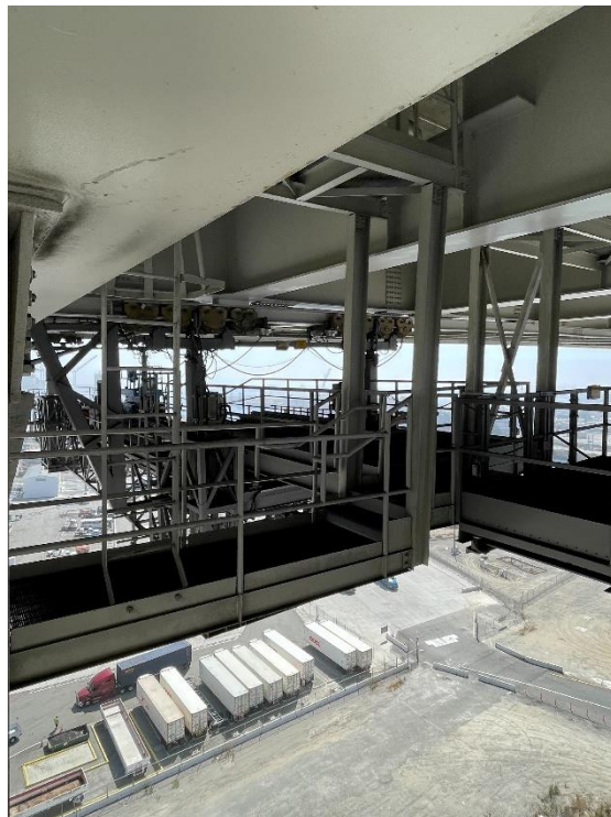
東西向移動式維修平台各自分離(長灘國際門戶大橋)
