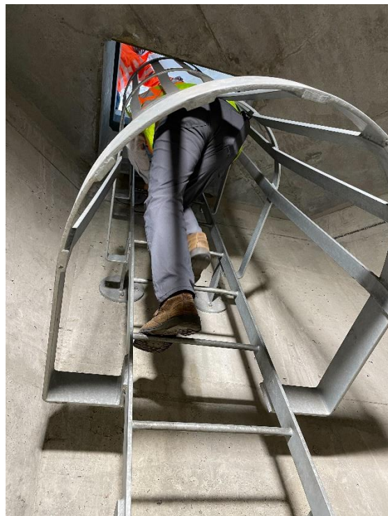
升降梯頂到維修平台之護籠爬梯(長灘國際門戶大橋)
