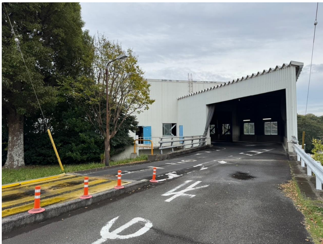
圖 11. 垃圾車進廠道路
