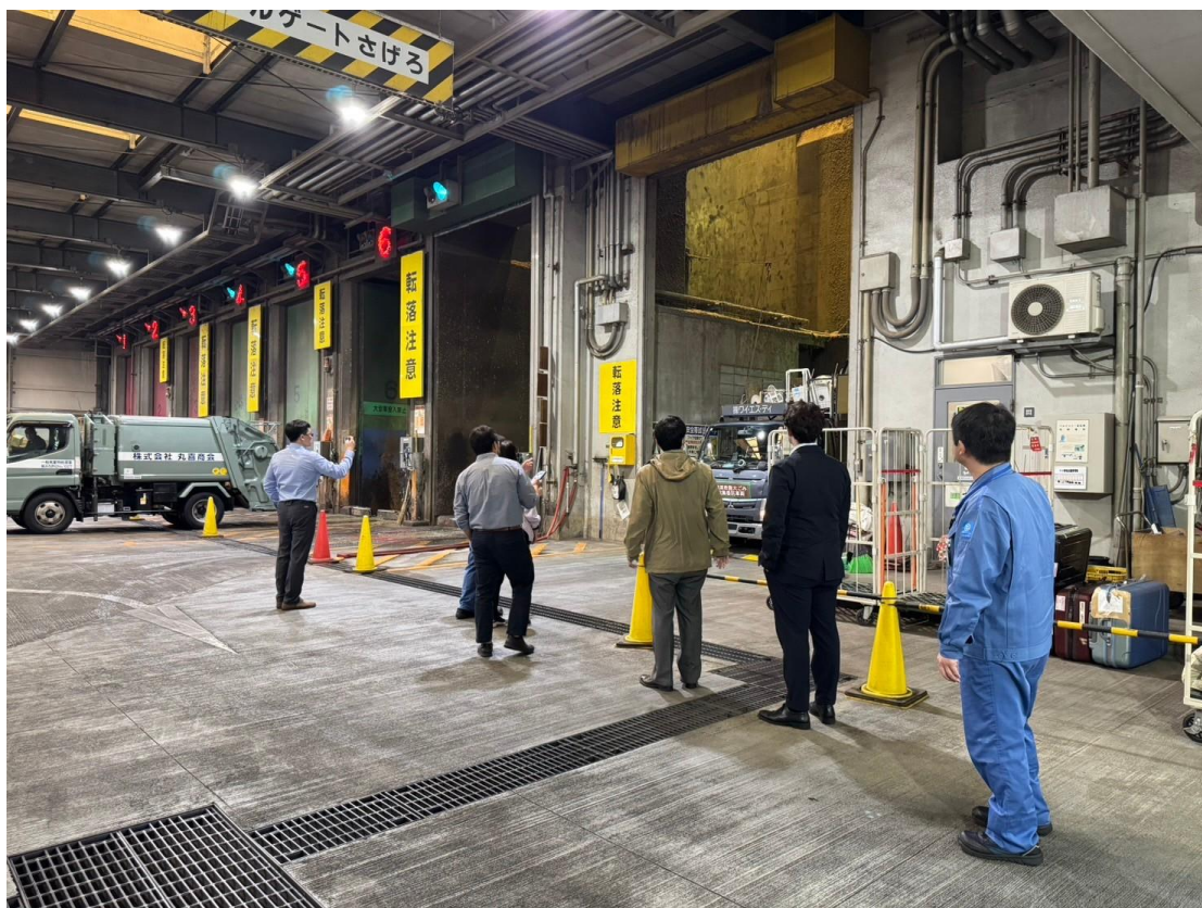
圖 18. 該廠設有 6 個傾卸平台
