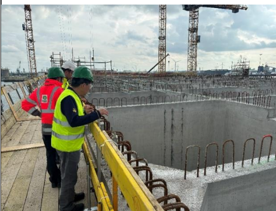
沉箱內部拖至海上定位後灌漿
